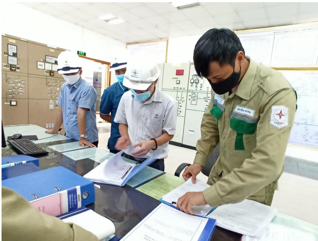
Đoàn kiểm tra phương án phòng chống mưa bão tại TBA 500 kV Hà Tĩnh
