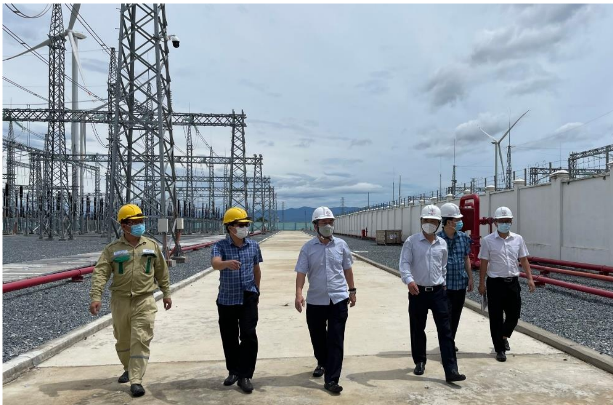
Tổng Giám đốc Phạm Lê Phú kiểm tra công tác QLVH tại TBA 220 kV Ninh Phước
