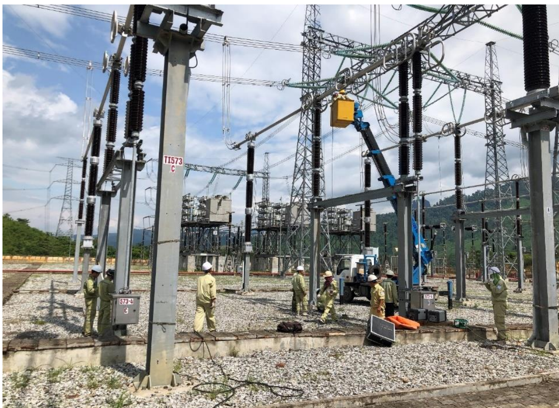
Thí nghiệm hiệu chỉnh thiết bị Dự án đường dây 500kV Dốc Sỏi - Pleiku 2 tại TBA 500 kV Dốc Sỏi
