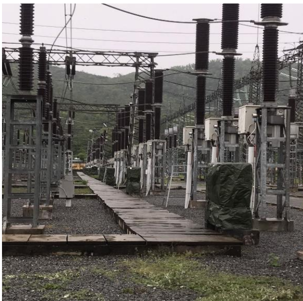
Thiết bị được chằng néo tại TBA.
