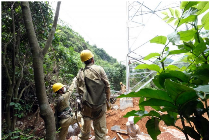
Thi công cột 85 đường dây 500kV Nho Quan - Thường Tín đảm bảo an toàn, đúng tiến độ theo phương án
