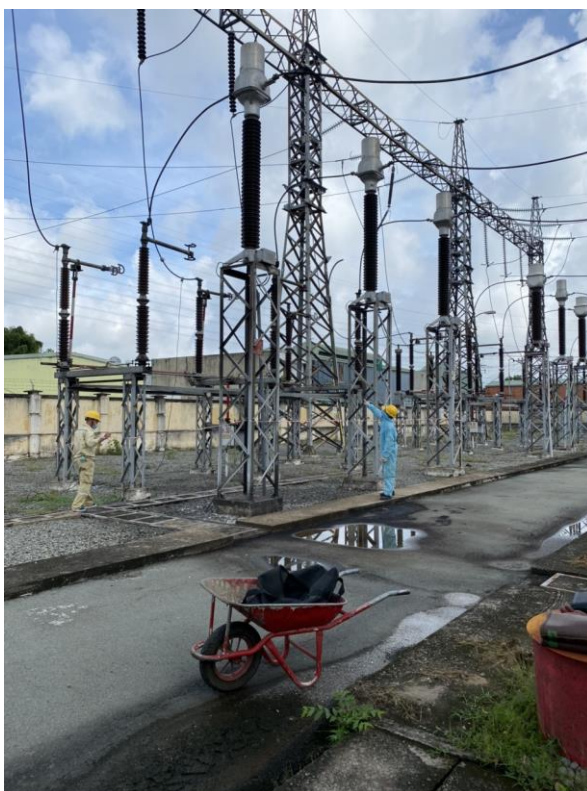
Bàn giao khu vực được phép làm việc.
