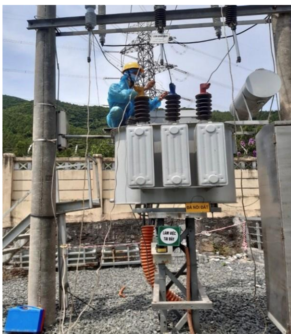
Công nhân TTDVKT1 thi công trên công trường
