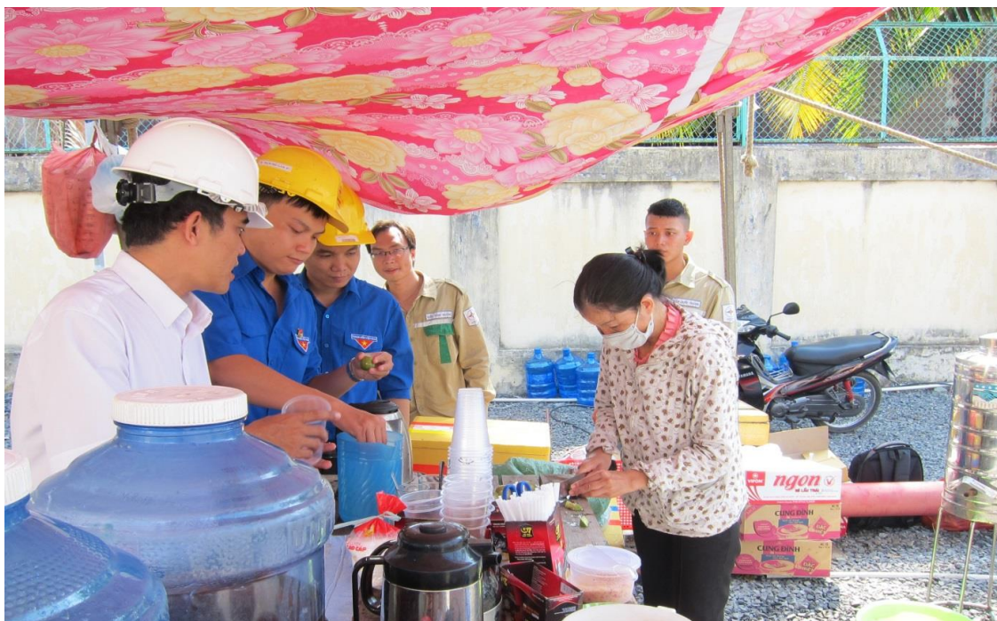
Chị Nguyễn Thị Thán tham gia chuyến đi ủy lạo công trường thi công thay MBA 900 MVA trạm 500kV Phú Lâm.
