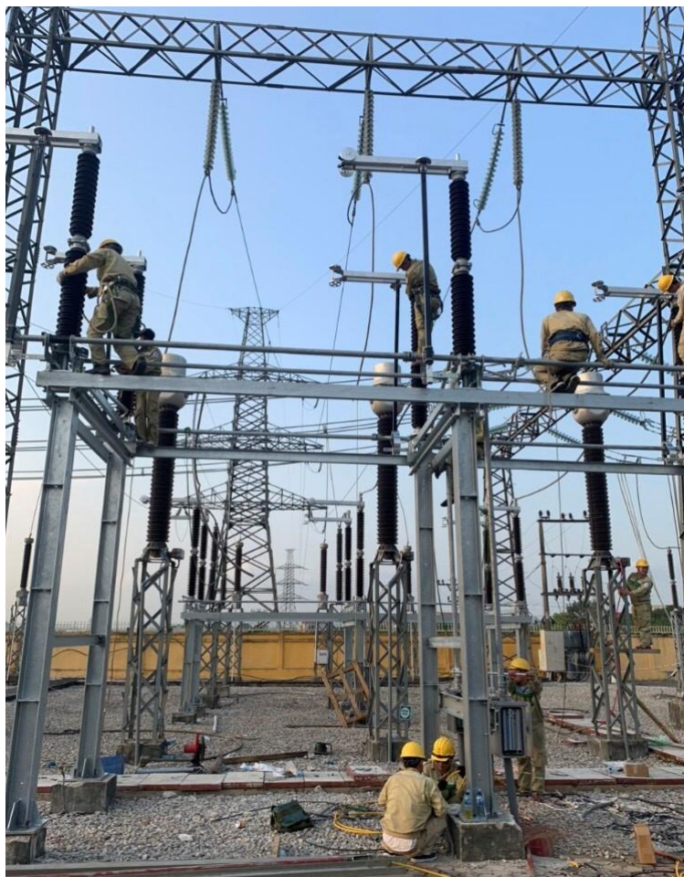
Anh cùng đồng đội thi công trên công trường TBA 500 kV Nho Quan tháng 4 năm 2021
