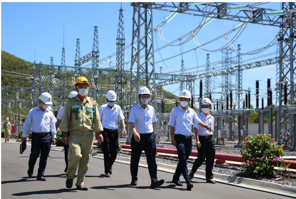
Tổng Giám đốc Phạm Lê Phú kiểm tra công tác QLVH tại TBA 220 kV Vân Phong (Ninh Hòa - Khánh Hòa)
