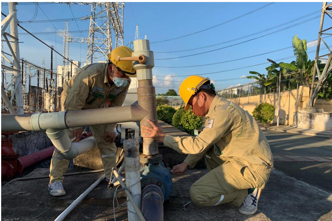
Ngoài thời gian trực ca vận hành, công nhân TBA kiểm tra hệ thống thoát nước nhằm chuẩn bị tốt cho mùa mưa bão
