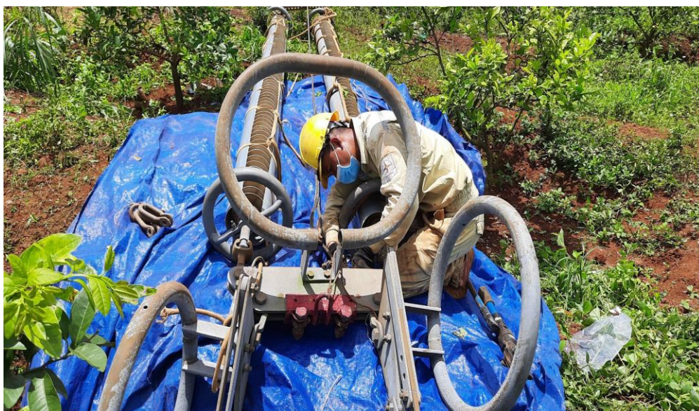
PTC3 xử lý độ cao pha đất khoảng cột (2986 - 2987) của khoảng néo (2984 - 2992) đường dây 500kV Đắk Nông - Cầu Bông
