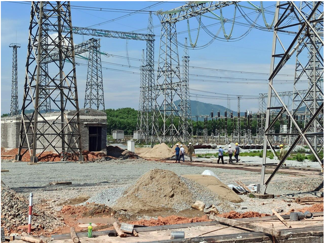
Đoàn công tác PTCI kiểm tra công tác an toàn công trình đang thi công trong TBA 500 kV Hà Tĩnh
