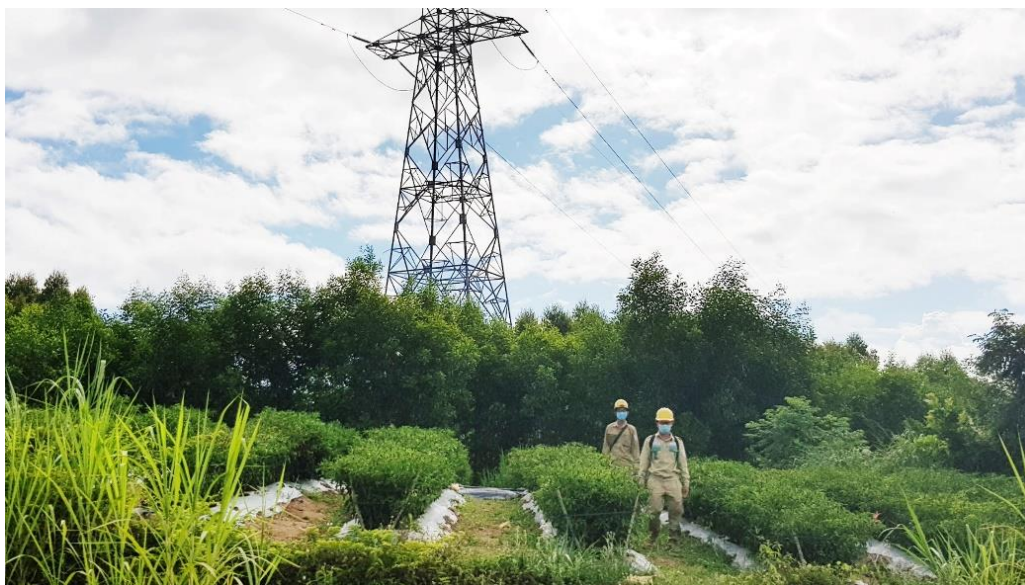
Đội TTĐ Quy Nhơn tuần tra, kiểm tra đường dây 220kV Pleiku2 - Phước An
