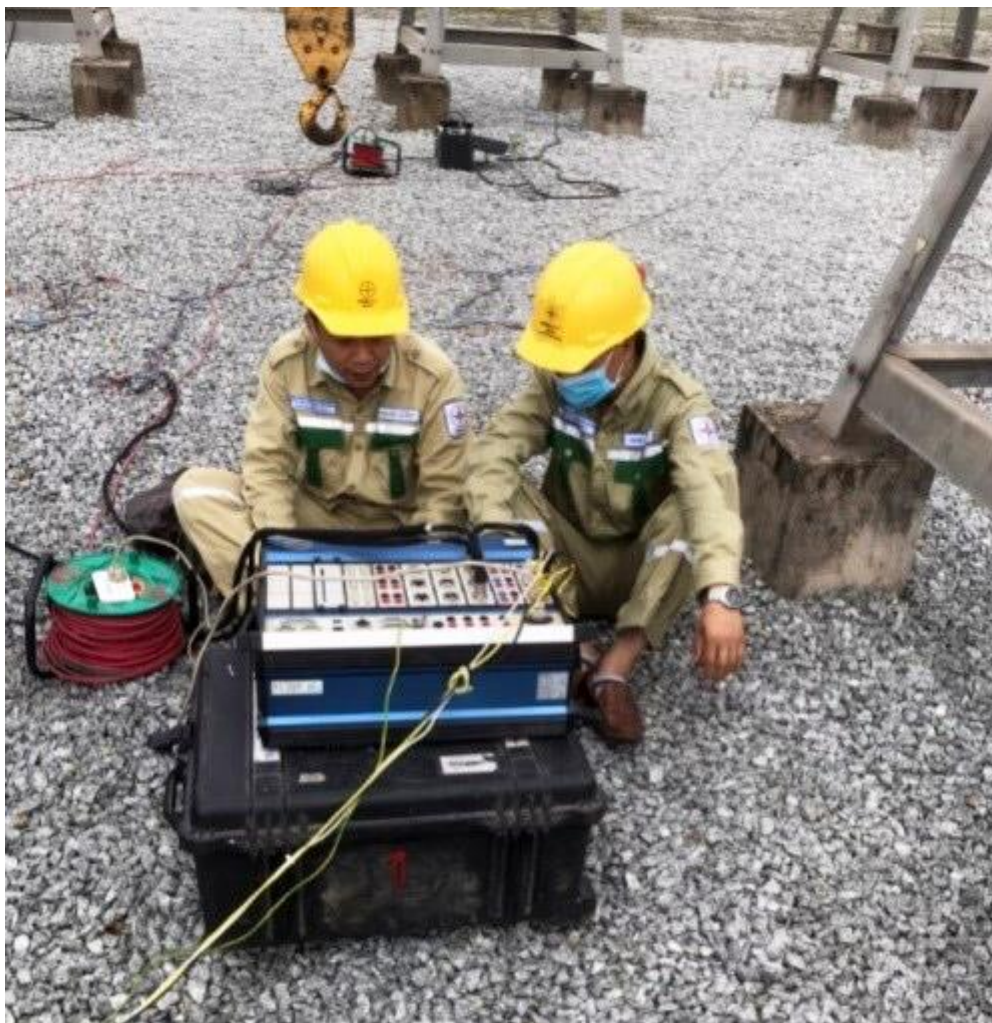
Công nhân TTDVKT1 thí nghiệm thiết bị sau lắp đặt tại TBA 500kV Hà Tĩnh.
