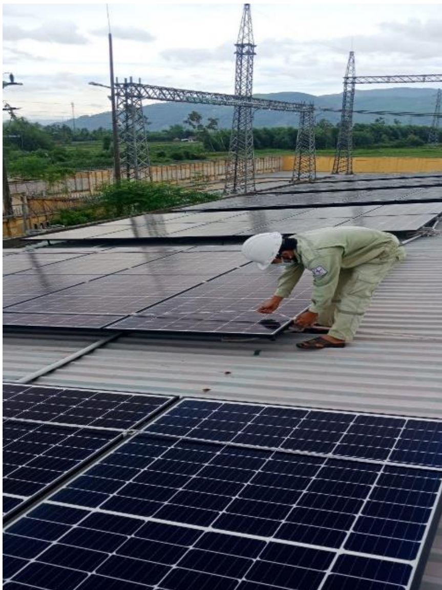
Lực lượng QLVH căng nêo thiết bị tại TBA.
