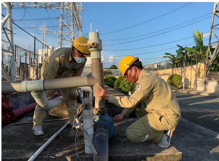
Ngoài thời gian trực ca vận hành, CBCNV thực hiện kiểm tra hệ thống thoát nước nhằm chuẩn bị tốt cho mùa mưa bão
