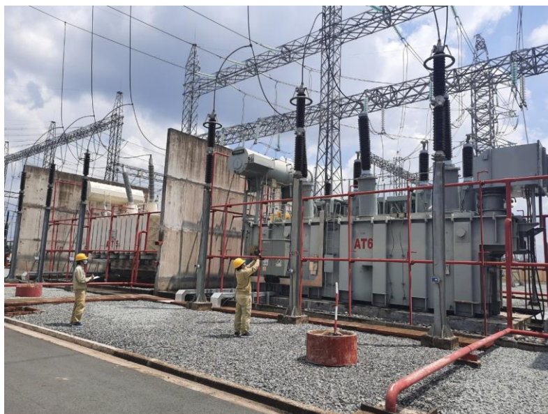
Điều hành viên Trạm 500kV Tân Uyên đo kiểm tra nhiệt độ khi tải tăng cao.
