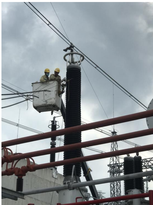
Xử lý vệ sinh đầu cột trạm 500kV Chơn Thành.
