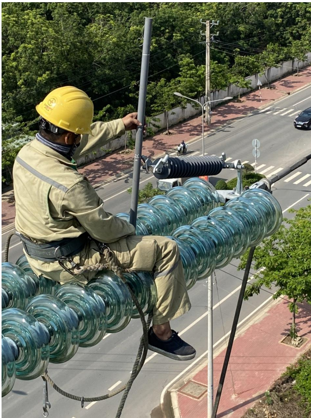
Kết hợp bảo dưỡng đường dây lắp tăng cường chống sét van.
