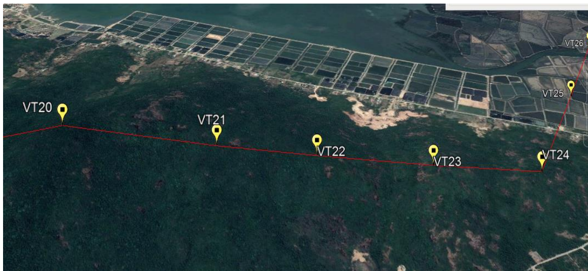
Ảnh chụp vệ tinh vị trí cột 20-24 của đường dây trên địa bàn tỉnh Khánh Hòa sẽ được thi công trong thời gian tới
