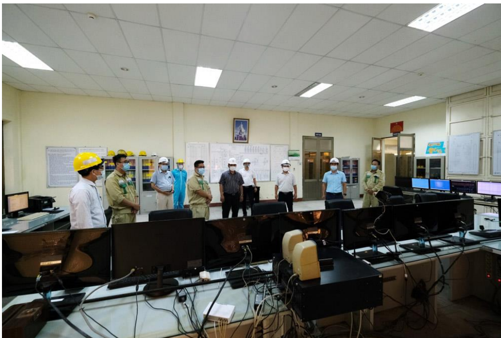
Lãnh đạo Công ty truyền tải điện 1 đến kiểm tra công tác đảm bảo an toàn lưới điện tại trạm 500kV Thường Tín sáng ngày 20/5
