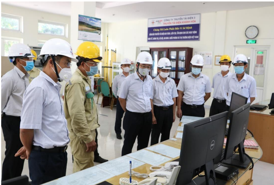
Tổng Giám đốc Phạm Lê Phú kiểm tra công tác QLVH tại TBA 220kV Nha Trang
