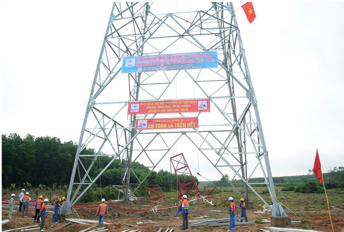
Thi công đường dây 500 kV mạch 3 trên địa bàn tỉnh Quảng Nam còn gặp nhiều khó khăn do vướng BTGPMB
