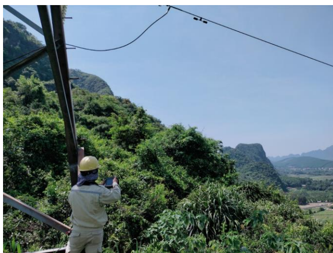
Đội TTD Nho Quan kiểm tra soi phát nhiệt tăng cường VT 120 đường dây 220kV Nho Quan - Phú Lý
