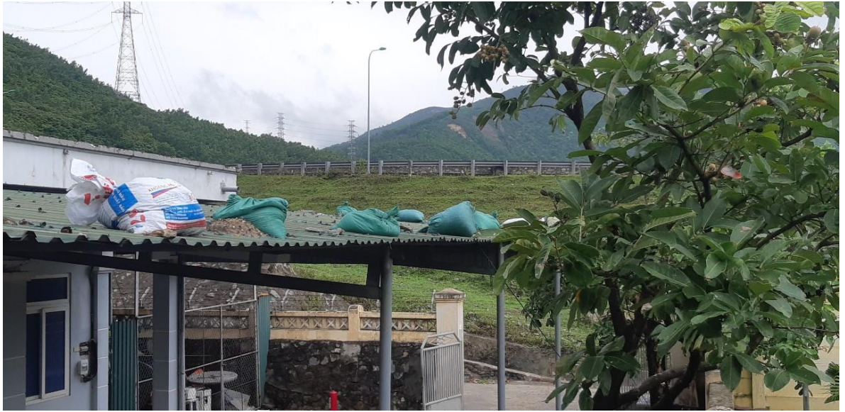
Chủ động chuyển các bao cát lên mái tôn tránh bay mái tôn khi có mưa bão tại TBA 500 kV Vũng Áng
