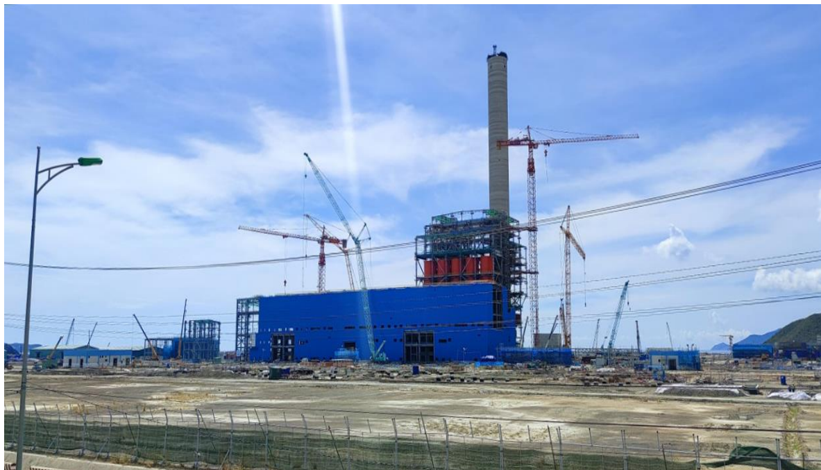
Vị trí sẽ xây dựng TBA 500 kV Vân Phong (Khánh Hòa)
