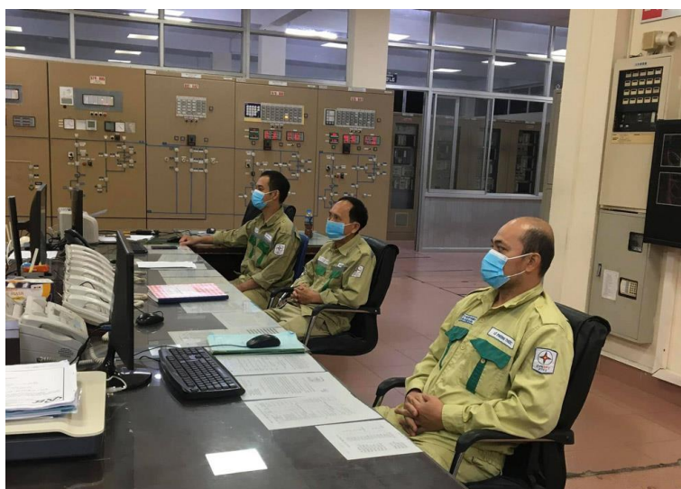
Công nhân Công ty Truyền tải điện 2 đảm bảo các yêu cầu về phòng chống dịch COVID-19 tại trạm biến áp
