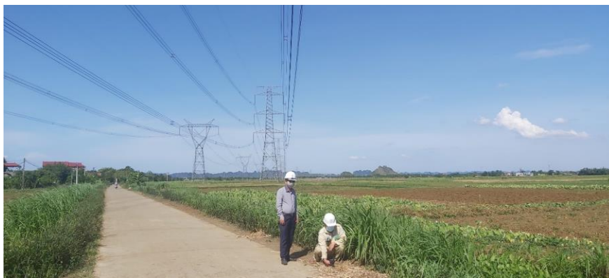
Đ/c Đỗ Đình Dũng - Phó Giám đốc TTD Ninh Bình kiểm tra khoảng cách pha - đất giữa cao điểm nắng nóng đường dây 500kV Nho Quan - Hà Tĩnh
