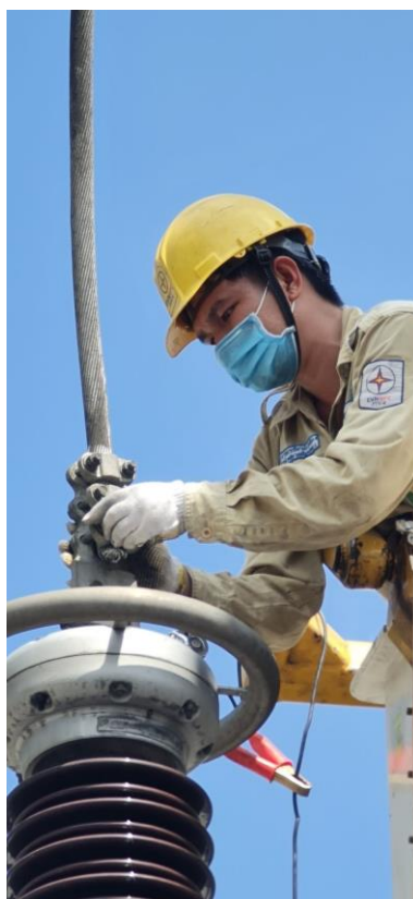
Hỗ trợ đơn vị Trung tâm dịch vụ kỹ thuật 4 (TTDVKT4) tháo đầu cột đo thí nghiệm định kỳ thiết bị.
