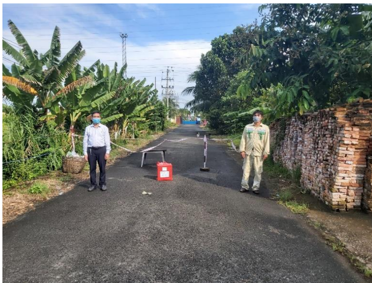
Trạm 220kV Sóc Trăng
