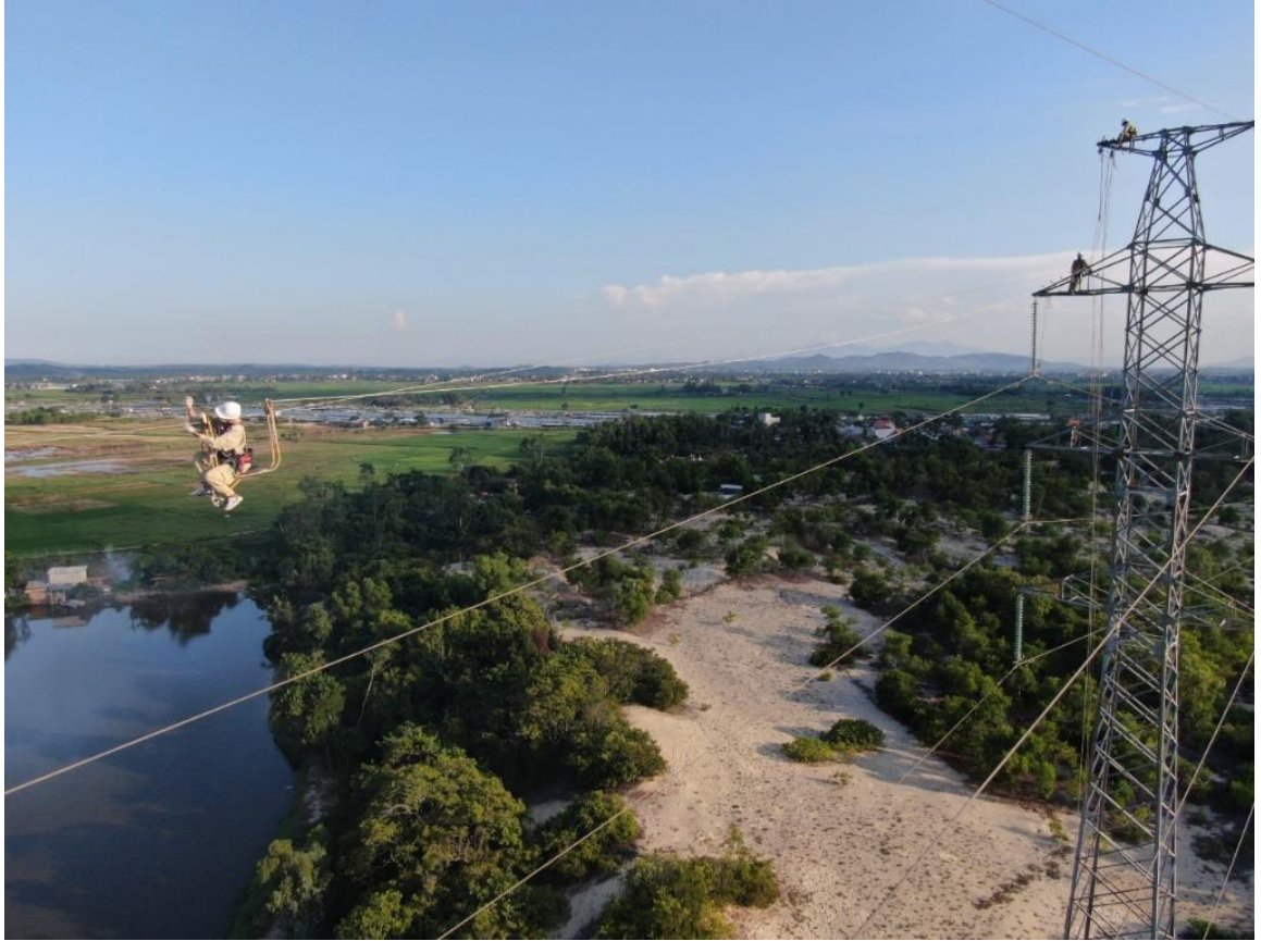
Công nhân PTC2 kiểm tra, sửa chữa lưới TTD đảm bảo vận hành an toàn liên tục
