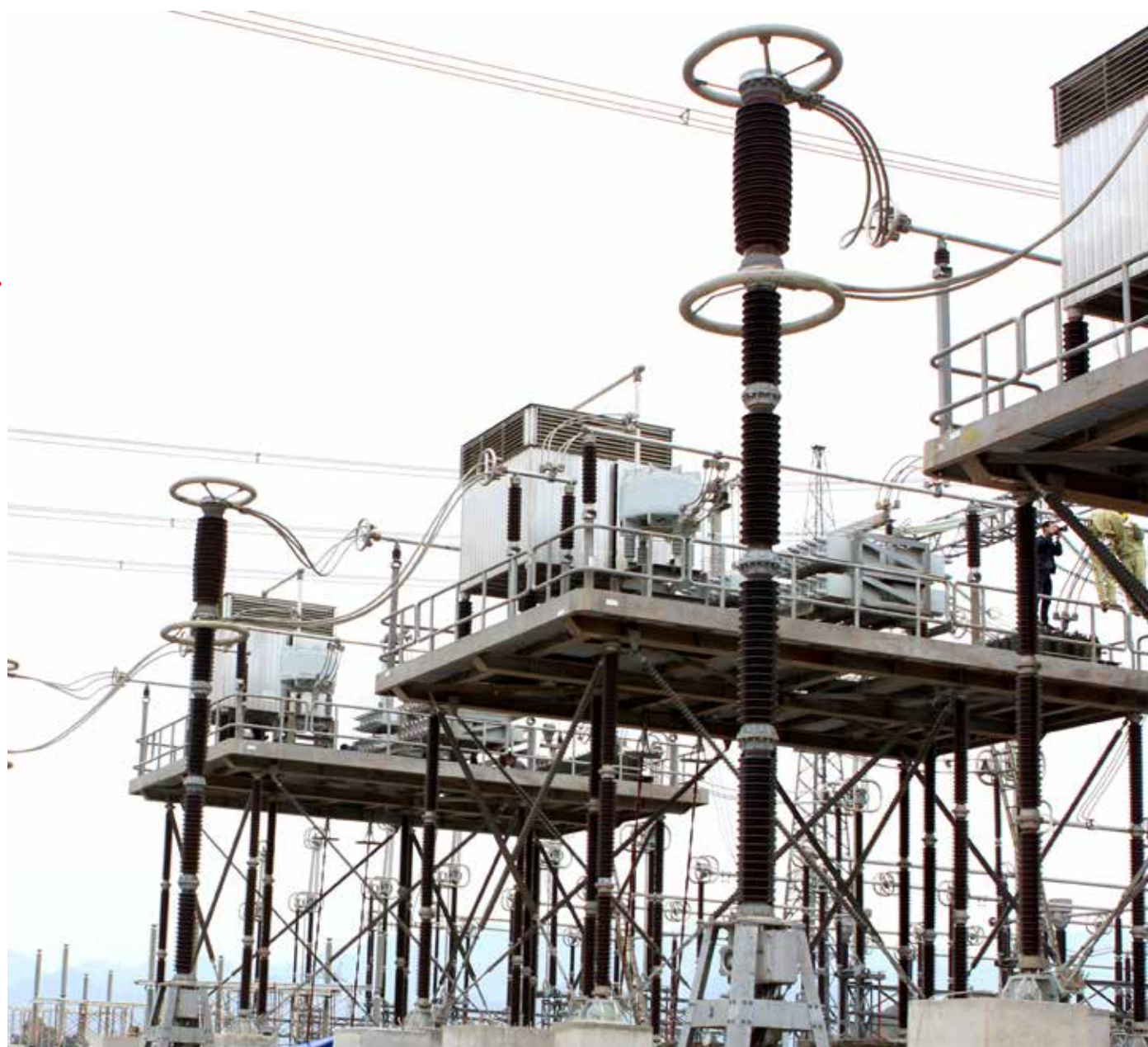
Thi công đàn tụ bù tại TBA 500kV Nho Quan (ảnh Vũ Lam)
