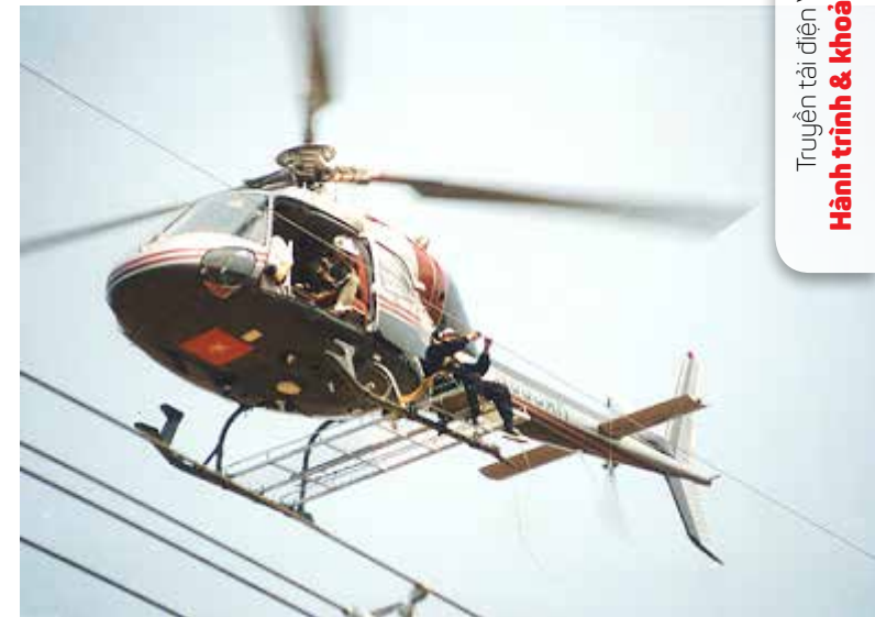
Sử dụng trực thăng sửa chữa cáp quang OPGW đường dây 500kV mạch 1 (ảnh tư liệu)
