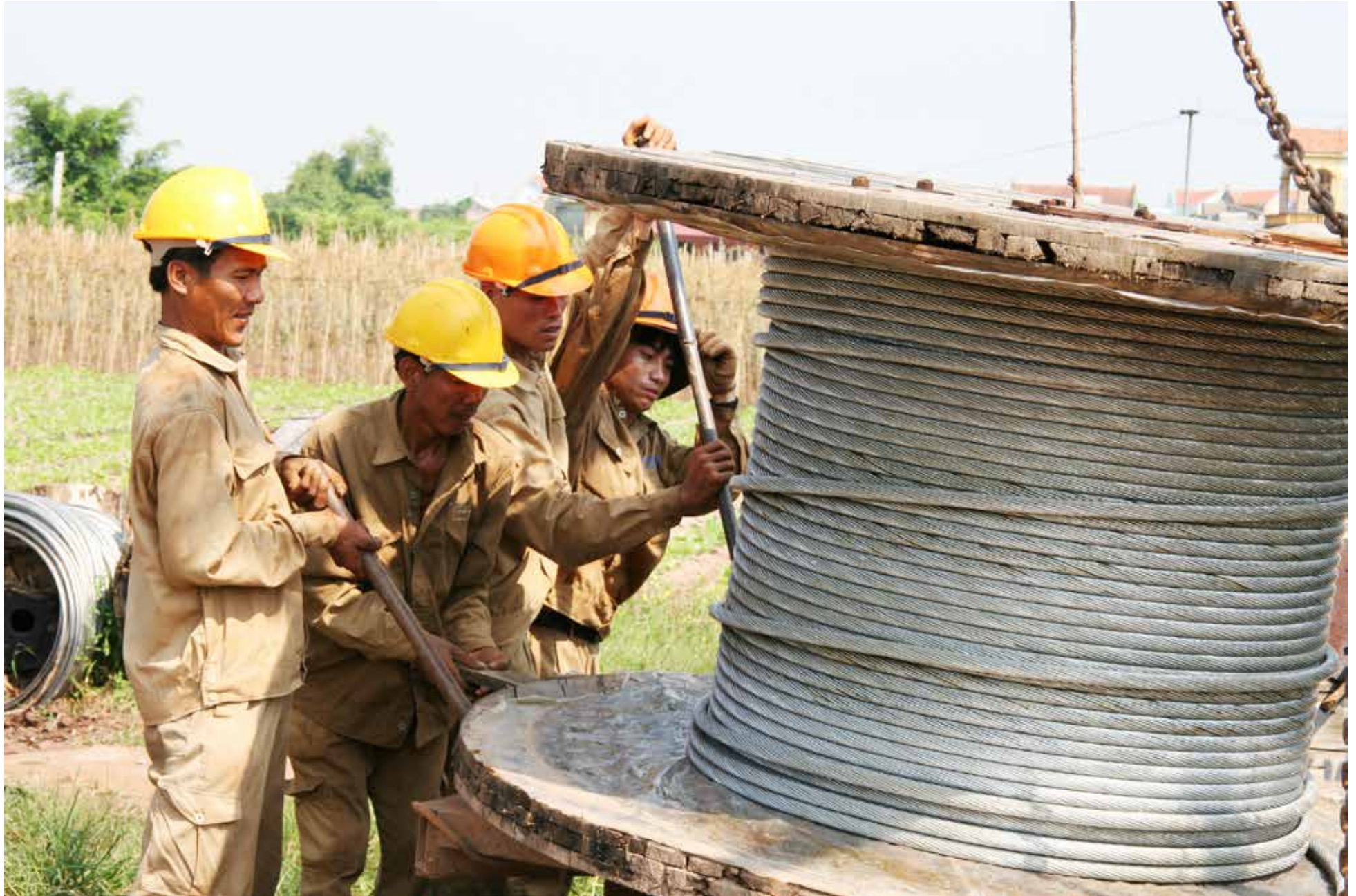
Thi công đường dây 500kV Quảng Ninh - Thường Tín (ảnh Vũ Lam)
