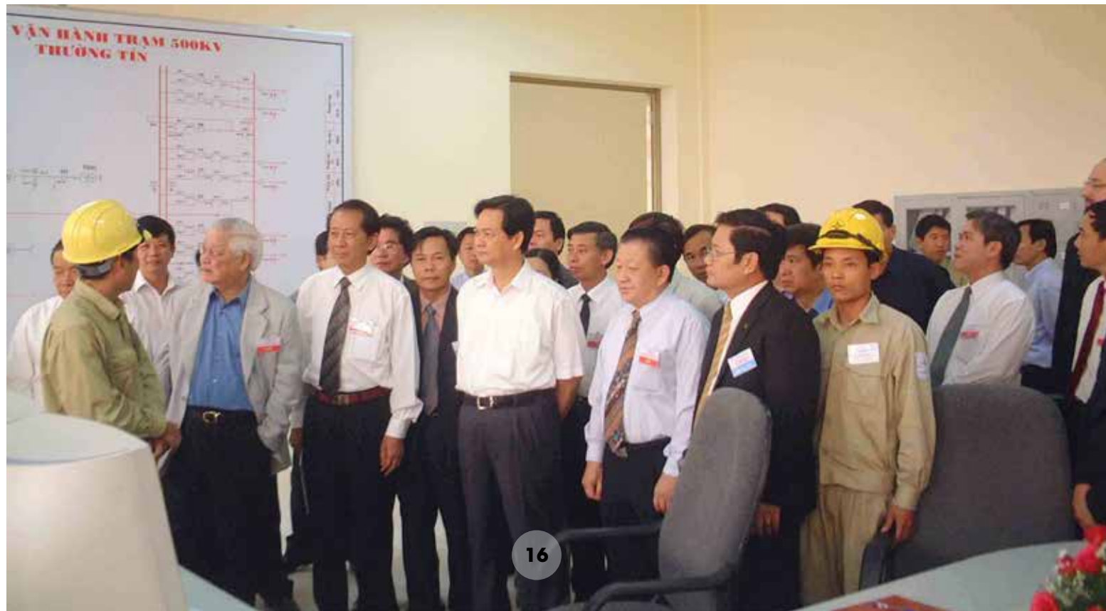
Phó Thủ tướng Nguyễn Tấn Dũng thăm trạm 500kV Thường Tín (ảnh tư liệu)
