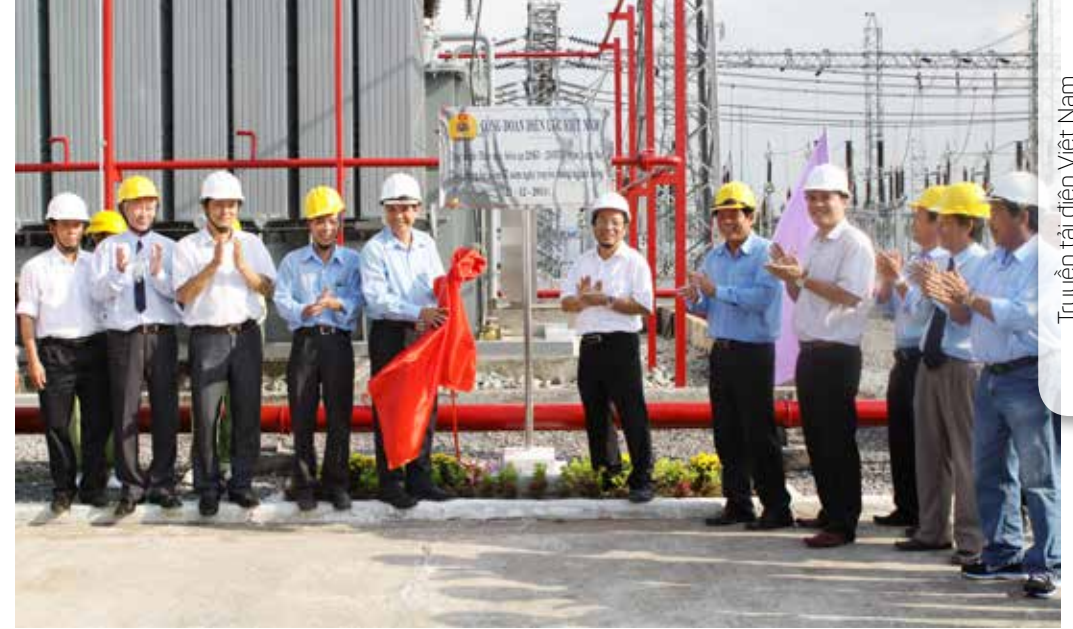
Lễ gắn biển công trình thay MBA 220kV - 250MVA Trạm Long An (ảnh CTV)
