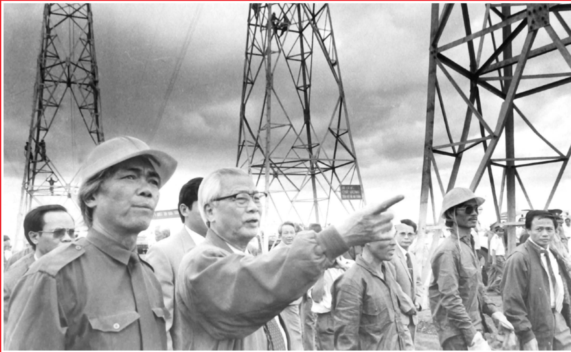
Thủ tướng Võ Văn Kiệt trong ngày hoàn thành đường dây 500kV mạch 1 (ảnh Nguyễn Công Thành)
