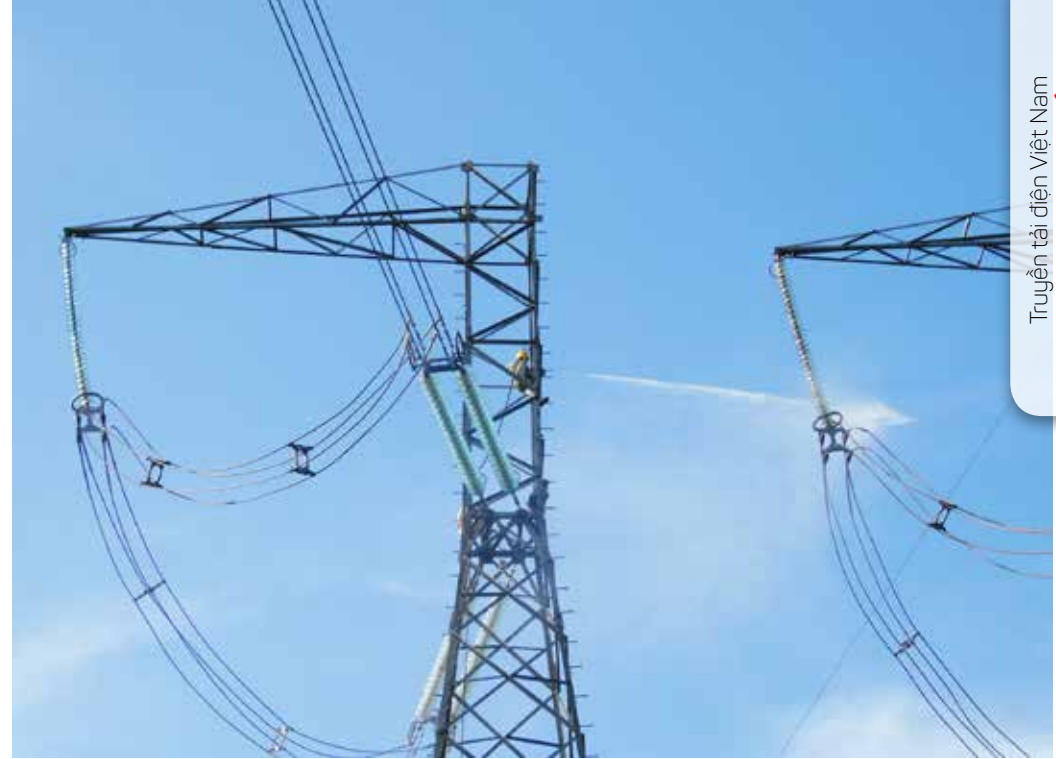
Ứng dụng công nghệ vệ sinh cách điện Hotline rửa sứ trên đường dây đang mang điện (ảnh CTV)
