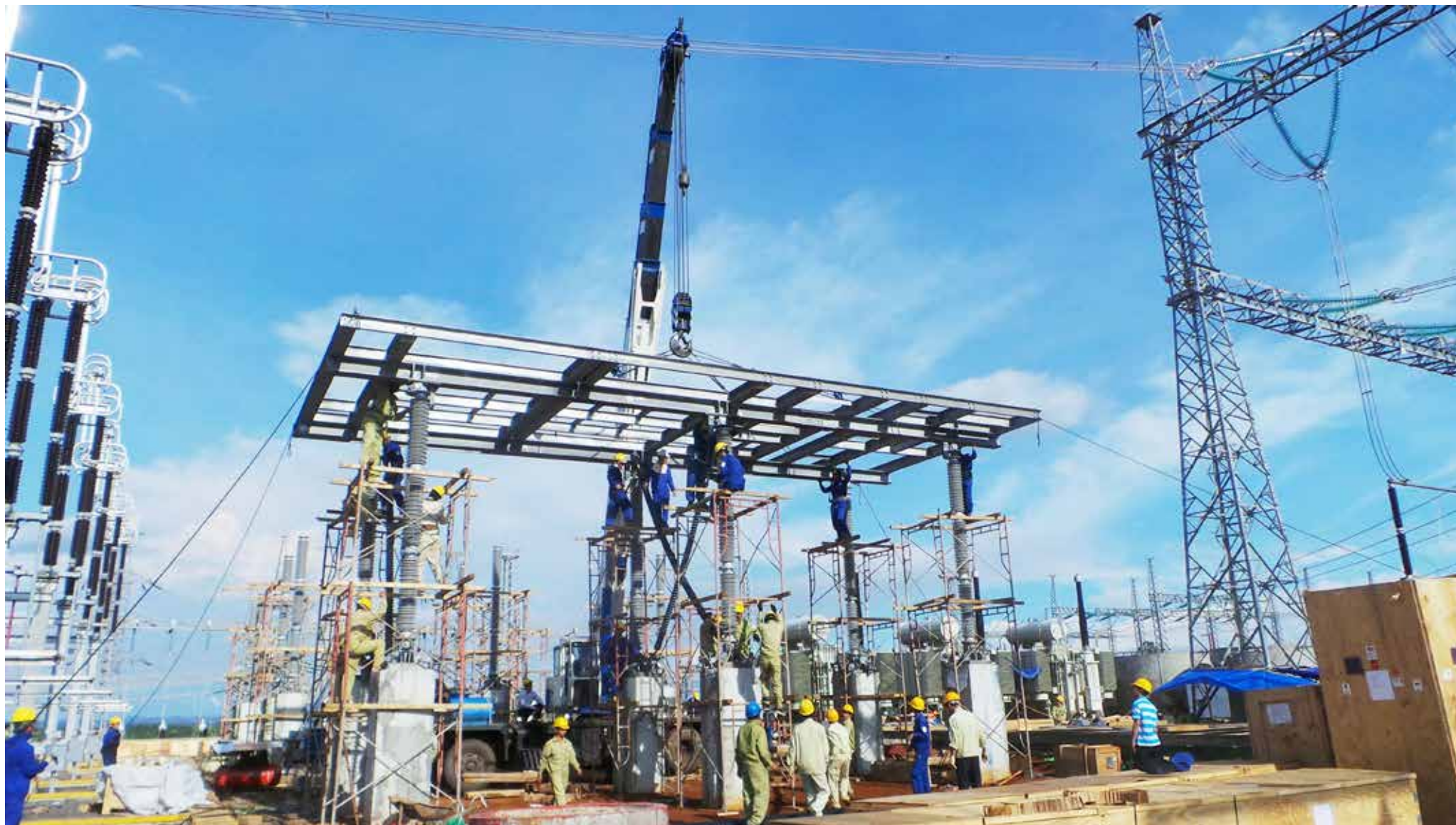
Thi công tủ bù TBA 500kV Đăk Nông (ảnh CTV)
