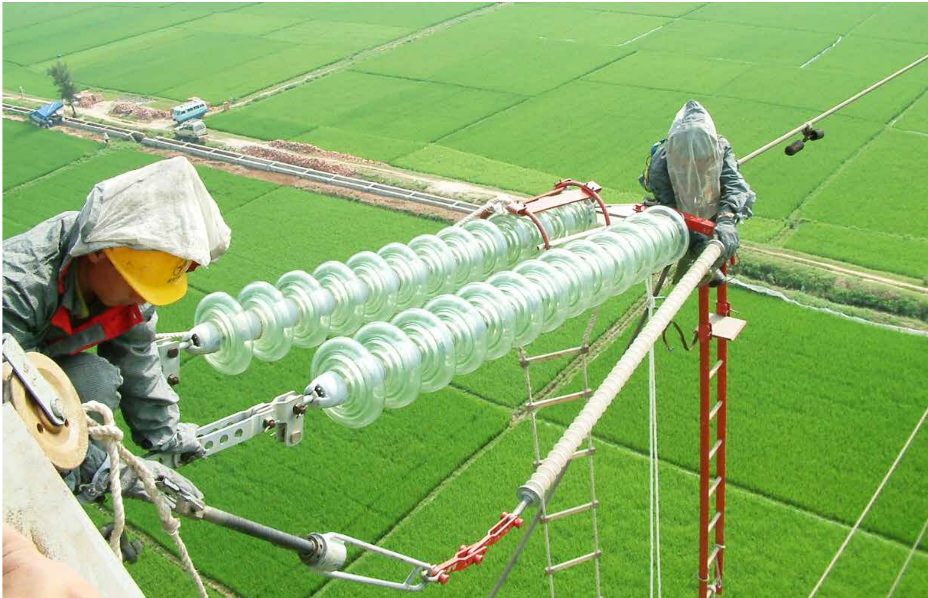
Sửa chữa điện nóng trên đường dây đang mang điện (ảnh Đỗ Đức Hùng)
