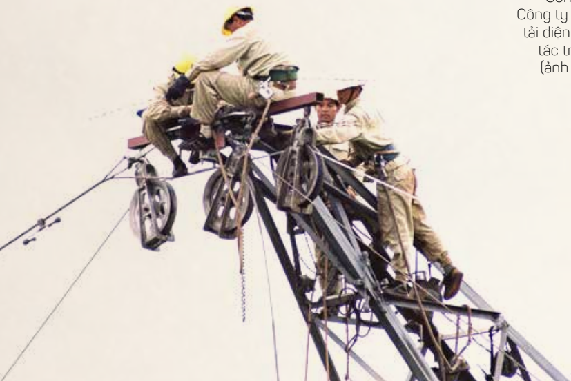
Công nhân Truyền tải điện Hòa Bình thi công thay dây cáp quang (ảnh Phan Cần)
