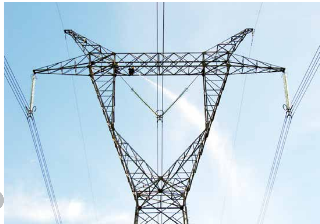
Ứng dụng công nghệ vệ sinh cách điện Hotline rửa sứ trên đường dây đang mang điện (ảnh CTV)
