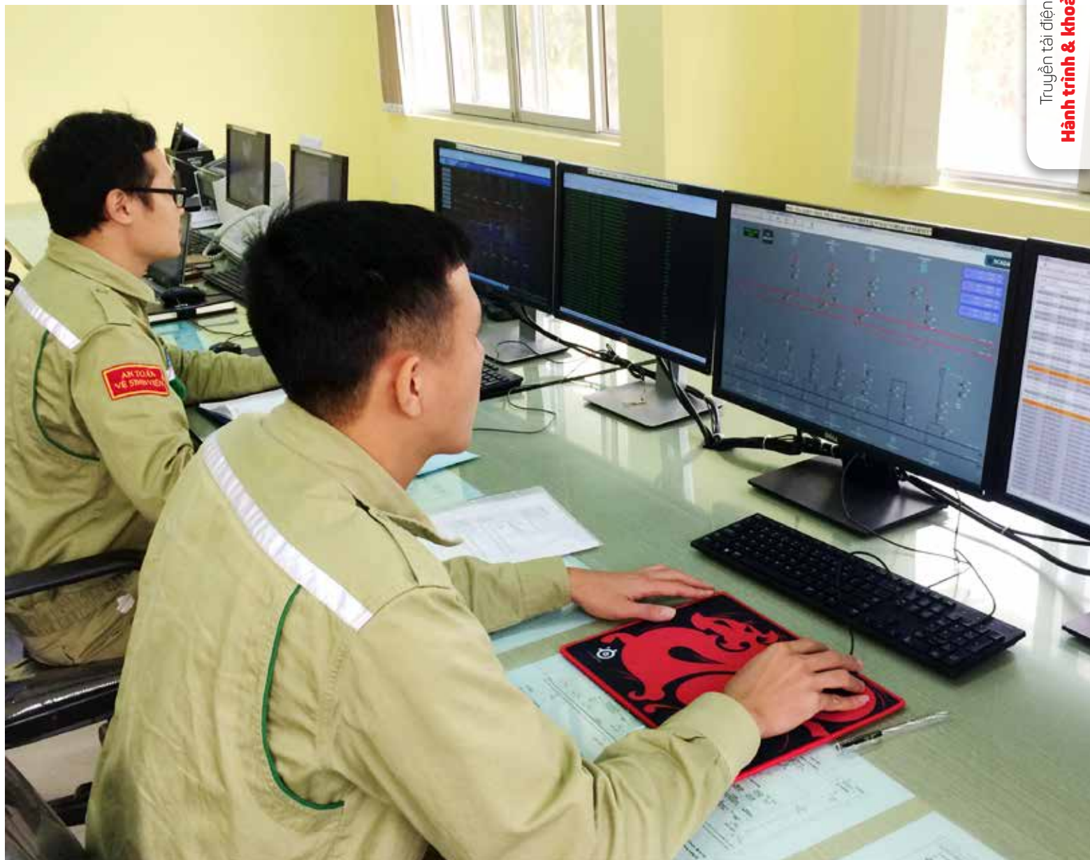
Trung tâm vận hành tại Nam Định theo dõi giám sát điều khiển TBA 220kV Thái Thụy - Thái Bình (ảnh CTV)
