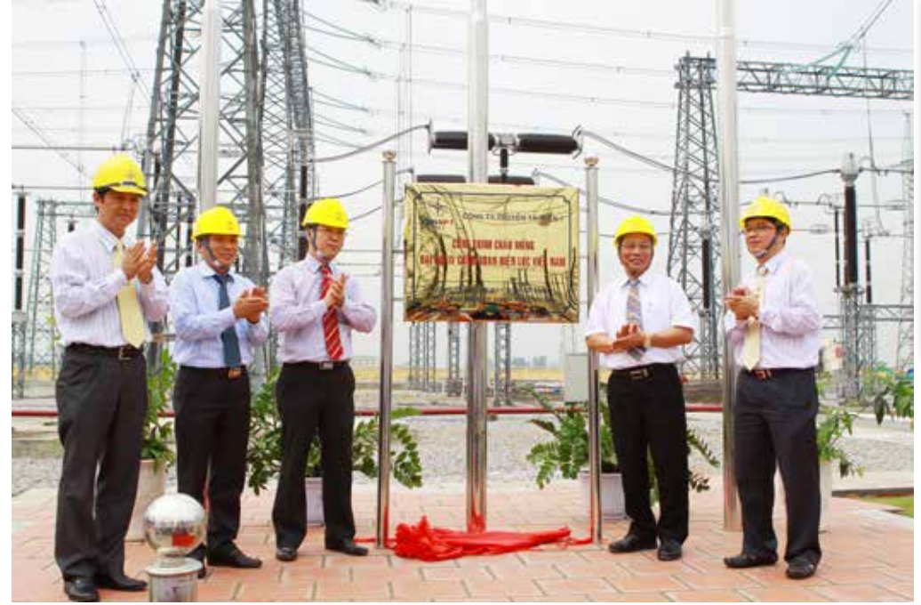
Lễ gắn biển công trình lắp máy biến áp 220kV tại Trạm biến áp 500kV Thường Tín - Hà Nội (ảnh CTV)
