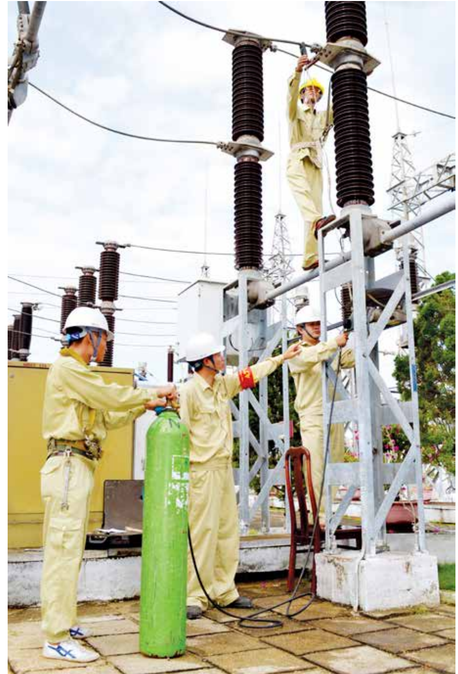
Kiểm tra hệ thống đường dây, nạp khí máy cắt, thay thế đèn tín hiệu hỏng là những công việc thường xuyên của nhân viên trực vận hành trạm (ảnh CTV)
