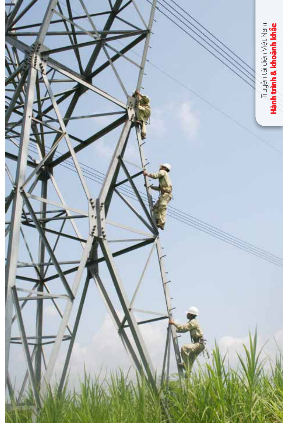
Công nhân truyền tải điện bảo dưỡng thiết bị đường dây 500kv mạch 2 (ảnh Vũ Lam)
