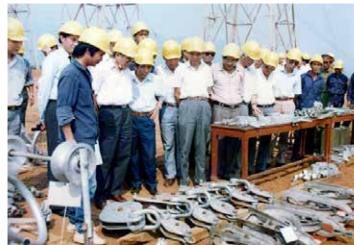
Bộ trưởng Vũ Ngọc Hải kiểm tra công trường thi công đường dây 500kV mạch 1 (ảnh Phan Cận)
