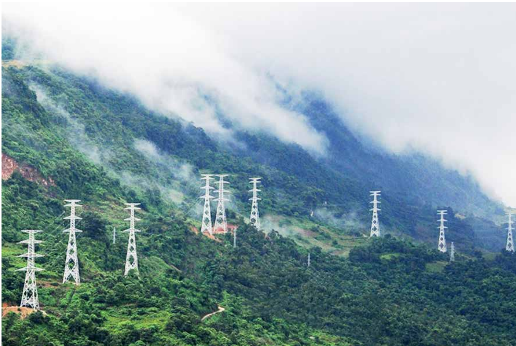
Hàng cột 500kV đang thi công trên tuyến Sơn La - Lai Châu (ảnh CTV)
