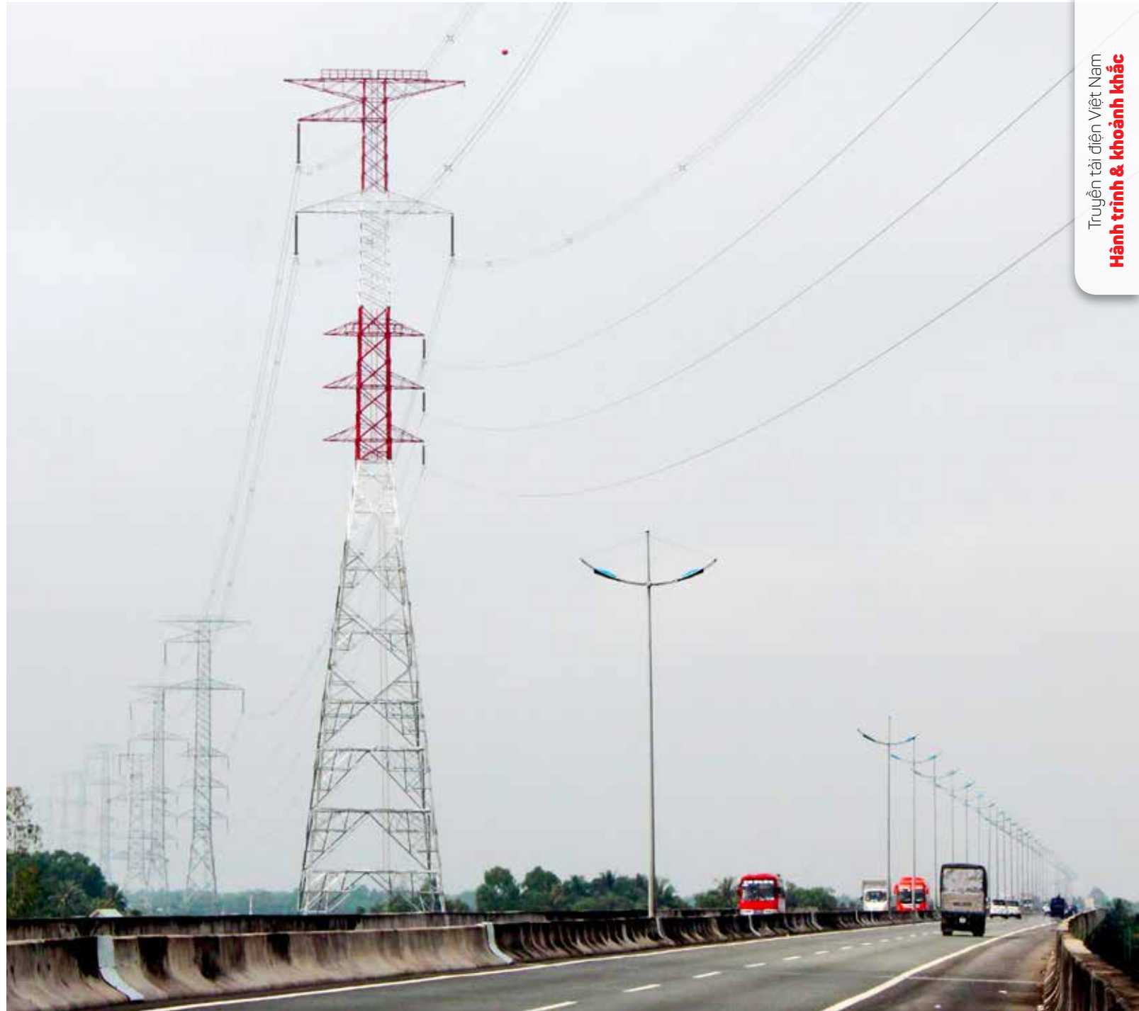
Đường dây 500kV Phú Lâm - Ô Môn (ảnh CTV)
