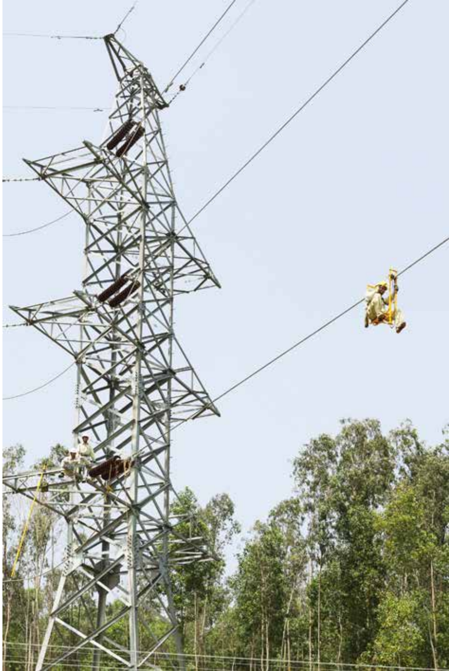
Công nhân truyền tải điện sử dụng xe đạp ra dây để di chuyển giữa các vị trí cột (ảnh CTV)
