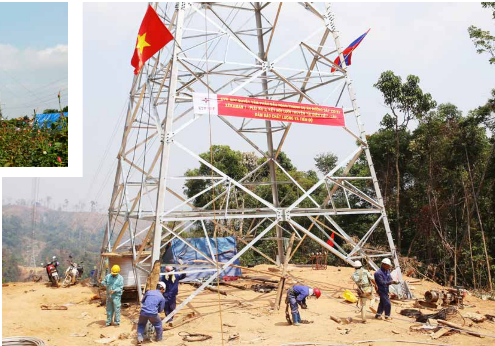
Thi công đường dây 220kV Xekaman1 - Pleiku 2 nối lưới Việt - Lào (ảnh CTV)
