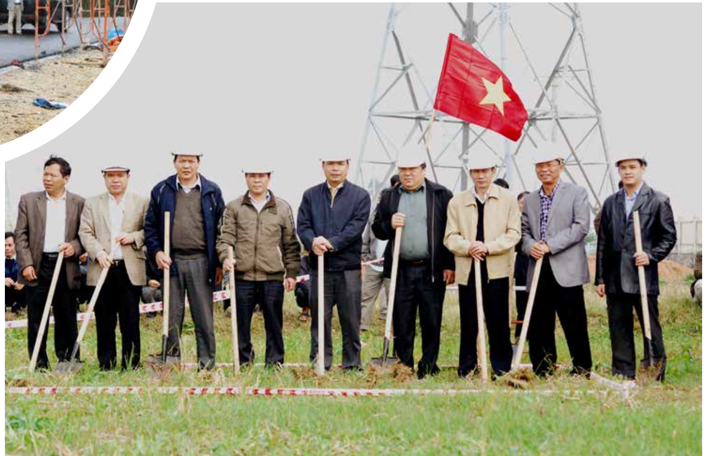
Khởi công công trình đường dây 220kV Vân Trì - Chèm (ảnh CTV)
