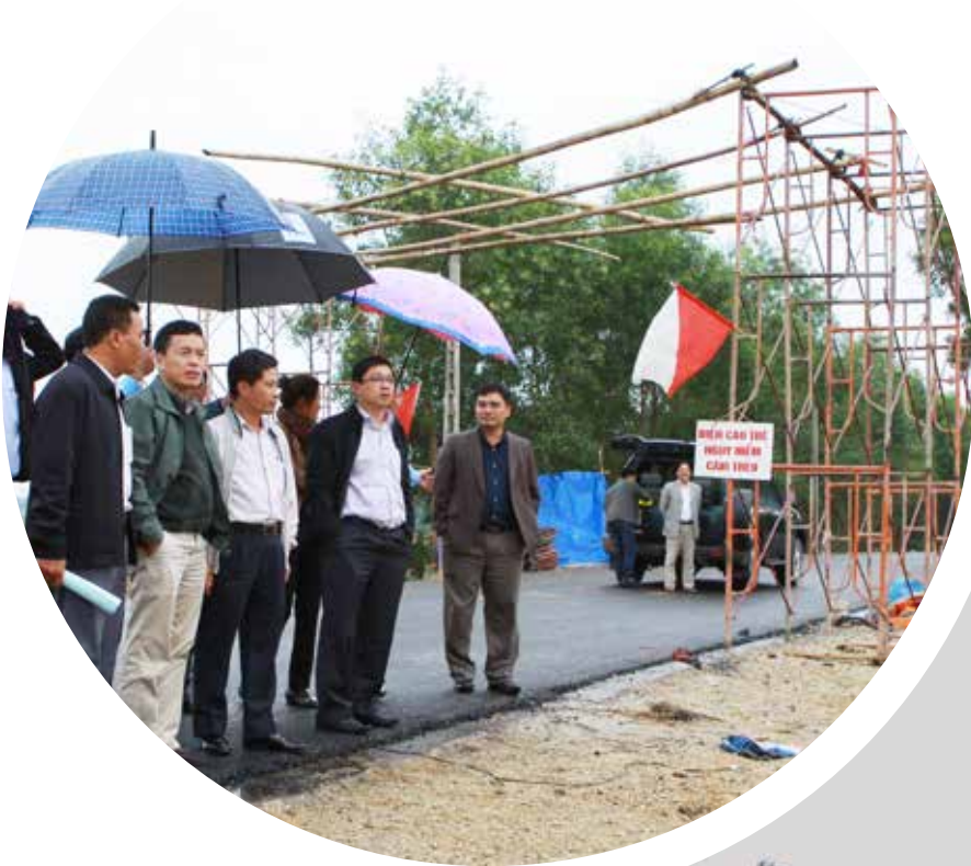
Lãnh đạo EVNNPT kiểm tra công trình thay dây siêu nhiệt đường dây 220kV Nho Quan - Ninh Bình (ảnh CTV)
