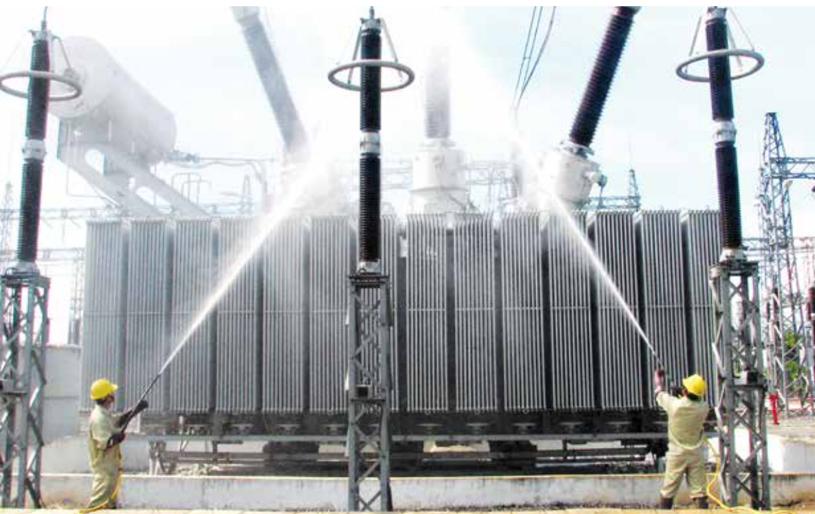
Nhân viên vận hành trạm vệ sinh máy biến áp, sứ bằng nước cách điện (ảnh CTV)
