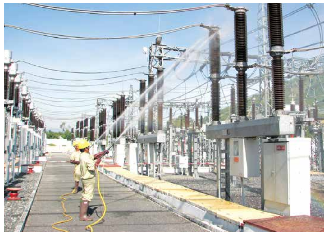
Nhân viên vận hành trạm vệ sinh máy biến áp, sứ bằng nước cách điện (ảnh CTV)
