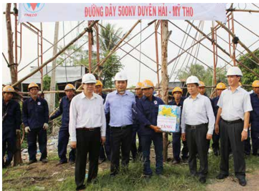
Lãnh đạo EVNNPT tặng quà công nhân trên công trường đường dây 500kv Duyên Hải - Mỹ Tho (ảnh CTV)
