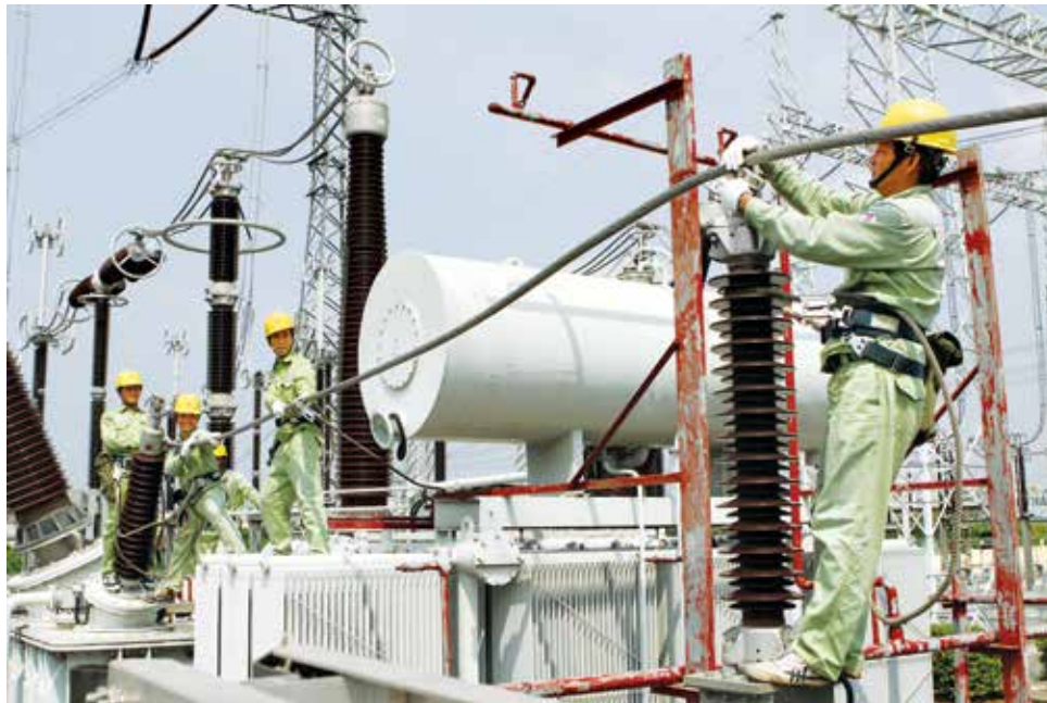
Kiểm tra hệ thống đường dây, nạp khí máy cắt, thay thế đèn tín hiệu hỏng là những công việc thường xuyên của nhân viên trực vận hành trạm (ảnh CTV)
