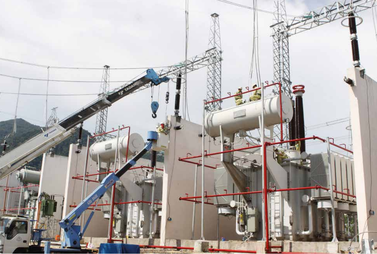
Lắp đặt MBA AT2 Trạm 500kV Thạnh Mỹ (ảnh CTV)
