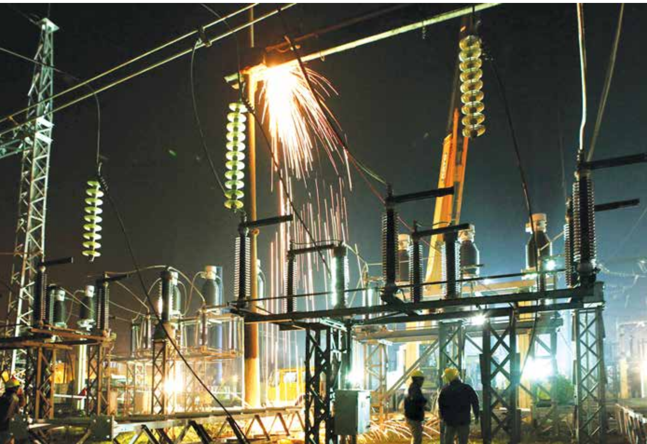
Thi công, sửa chữa thiết bị trong đêm tại TBA, tranh thủ thời gian thấp điểm của hệ thống (ảnh CTV)
