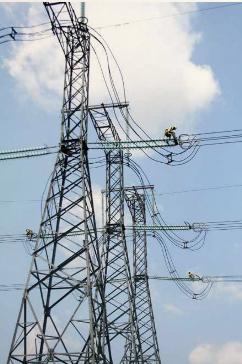
Công nhân Công ty Truyền tải điện 2 kiểm tra thiết bị đường dây 500kV mạch 2 (ảnh Vũ Lam)
