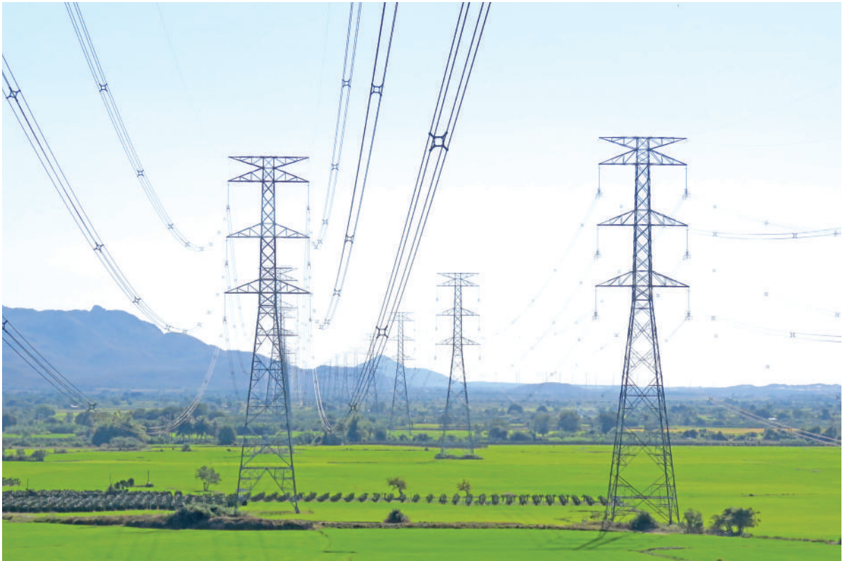
Hệ thống truyền tải điện Quốc gia hiện đã vươn tới tất cả các tỉnh, thành phố trên cả nước, kết nối với các nước trong khu vực như Trung Quốc, Lào, Campuchia. Trong ảnh: Đường dây 500kV Vĩnh Tân - Sông Mỹ và 500kV Vĩnh Tân - rẽ Sông Mỹ - Tân Uyên
