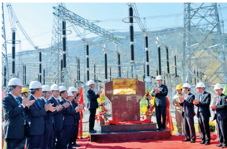
Lễ gắn biển Công trình để chào mừng Đại hội Đảng lần thứ XII: Đường dây 500kV Sơn La-Lai Châu và MR TBA 500kV Sơn La
