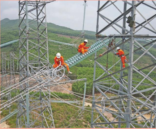
Công nhân PTC2 sửa chữa đường dây 500kV
