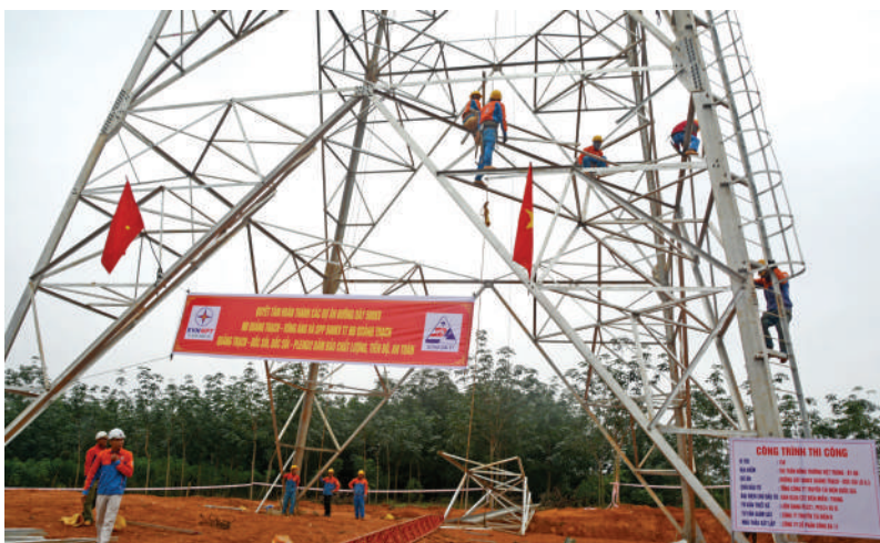
Nhà thầu thi công hạng mục cột thép dự án
