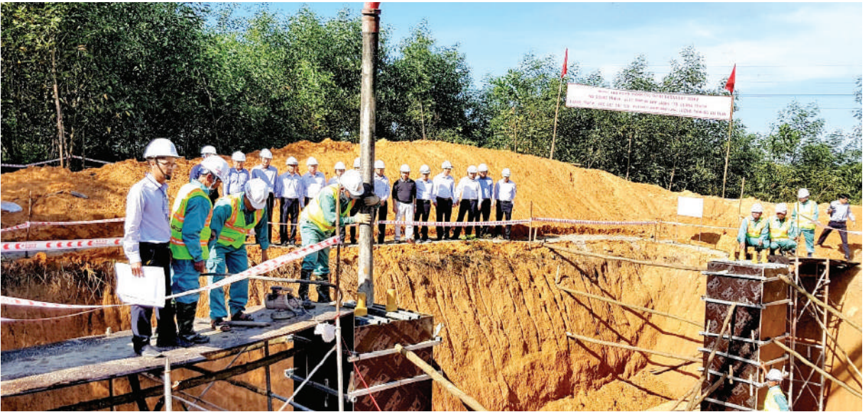
Lãnh đạo EVN, EVNNPT kiểm tra công tác thi công móng cột dự án
