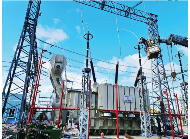
NTPMB triển khai dự án NCS TBA 220 kV Huế
