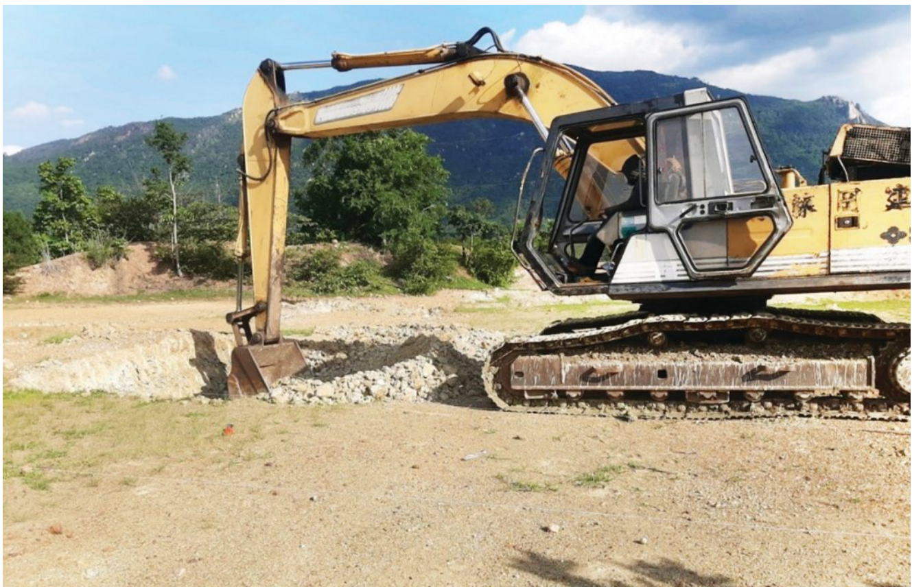
Đào hố móng vị trí 210, E2 500 kV Văn Phong - Vĩnh Tân
