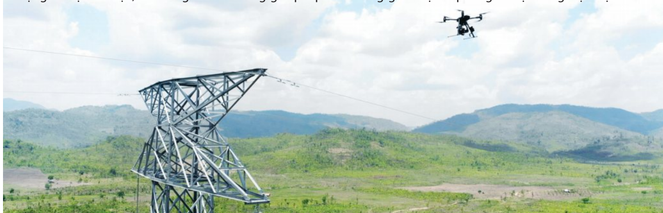
Sử dụng thiết bị bay kiểm tra sự cố đường dây tải điện
