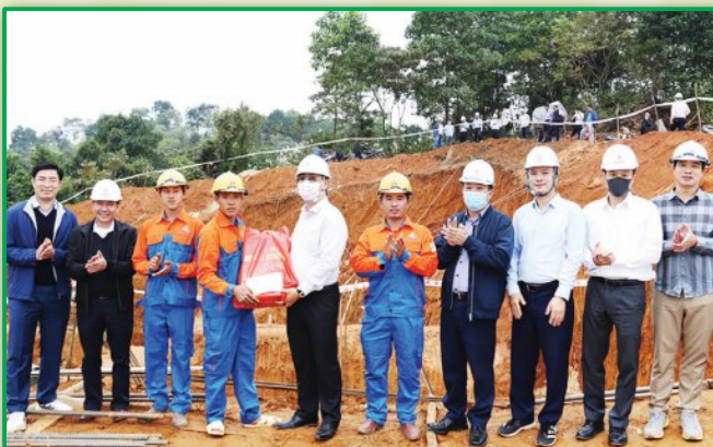
Đoàn cán bộ của EVN và EVNNPT do các ông Nguyễn Ngọc Tân - Thành viên HĐTV EVNNPT, ông Lưu Việt Tiến - Phó Tổng giám đốc EVNNPT dẫn đầu đi kiểm tra thi công và tặng quà lực lượng thi công tại công trình ĐZ 220 kV Lào Cai - Bảo Thắng trên địa bàn tỉnh Lào Cai (ngày 29 - 30/12/2021)
