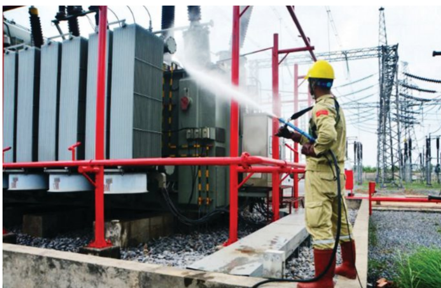
Sử dụng công nghệ hotline để vệ sinh MBA
