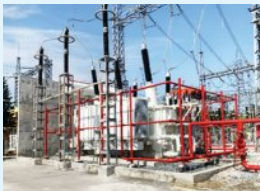
Lắp đặt hoàn thiện MBA AT2 - 250 MVA
