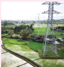
Cung đoạn ĐZ 220 kV Quảng Ngãi - Phù Mỹ thuộc dự án ĐZ 220 kV Quảng Ngãi - Quy Nhơn trước khi đóng điện
