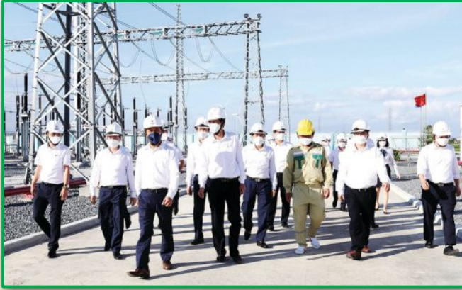
Chủ tịch Hội đồng Thành viên EVNNPT và đoàn công tác của Tổng công ty đã kiểm tra TBA 220 kV Ninh Phước, thuộc TĐĐ Ninh Thuận - PTC3 (ngày 11/1/2022)
