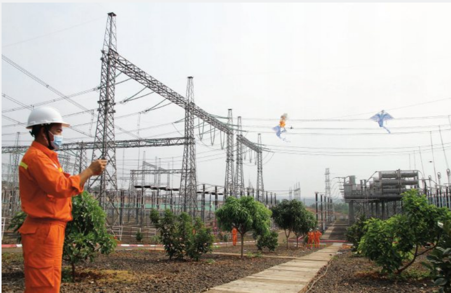
Thí sinh dự thi điều khiển UAV rồng lửa để đốt vật thể lạ vướng vào đường dây điện như diều, vật bay
