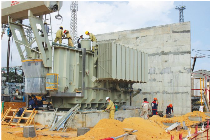
NPTS tham gia thi công dự án NCS TBA 220kV Ngũ Hành Sơn
