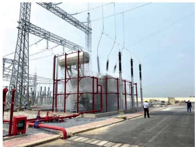
Nghiệm thu hệ thống phun sương MBA AT2
