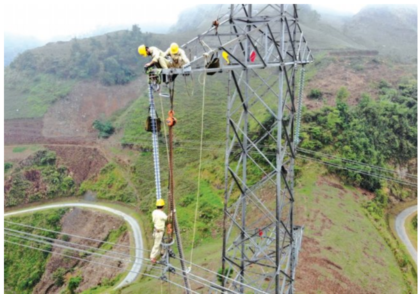
Nhóm công tác thay thế cách điện
