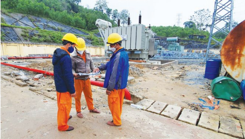
Các đơn vị thi công tại TBA 220kV Sơn Hà
