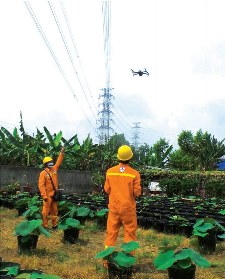
CBCNV đội TTD Phú Lâm sử dụng Flycam kiểm tra quản lý vận hành đường dây truyền tải điện
