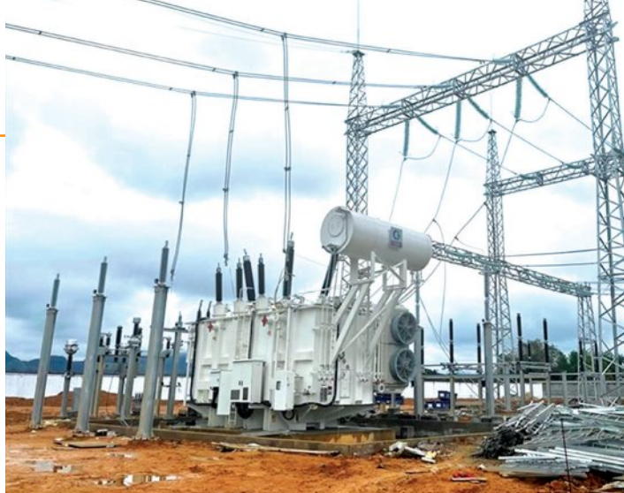
Thi công TBA 220kV Bắc Quang.
