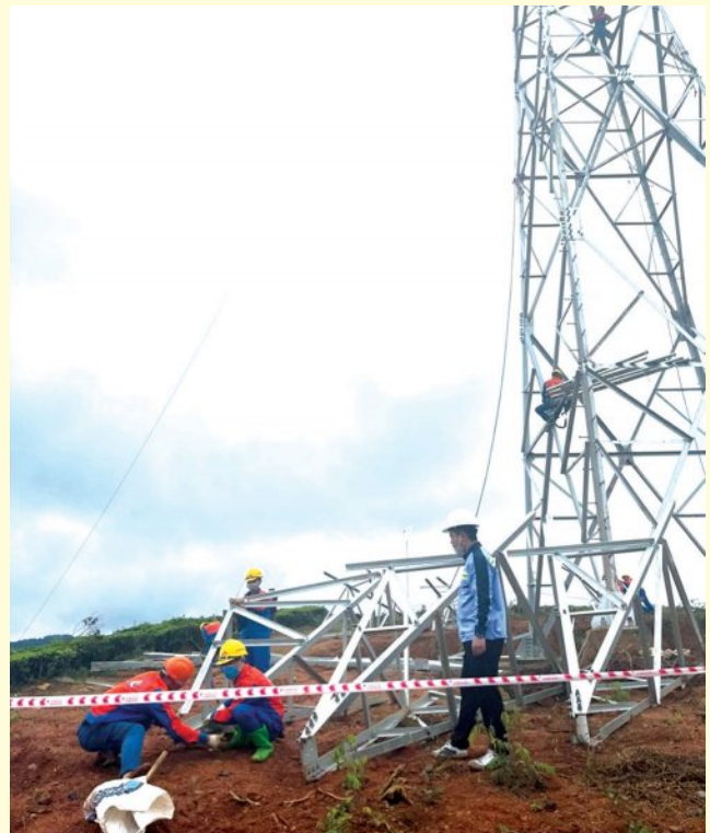
Công nhân Công ty CPSông Đà 11 đang lắp dựng cột vị trí 111
