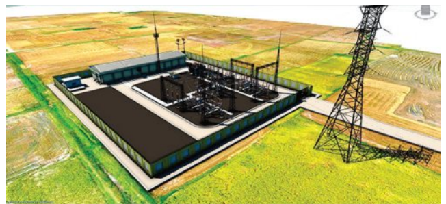
Trạm biến áp 220kV Krông Ana và đường dây đầu nối là TBA 220kV đầu tiên tại Việt Nam áp dụng mô hình thông tin công trình (BIM) trong đầu tư xây dựng, quản lý vận hành.
