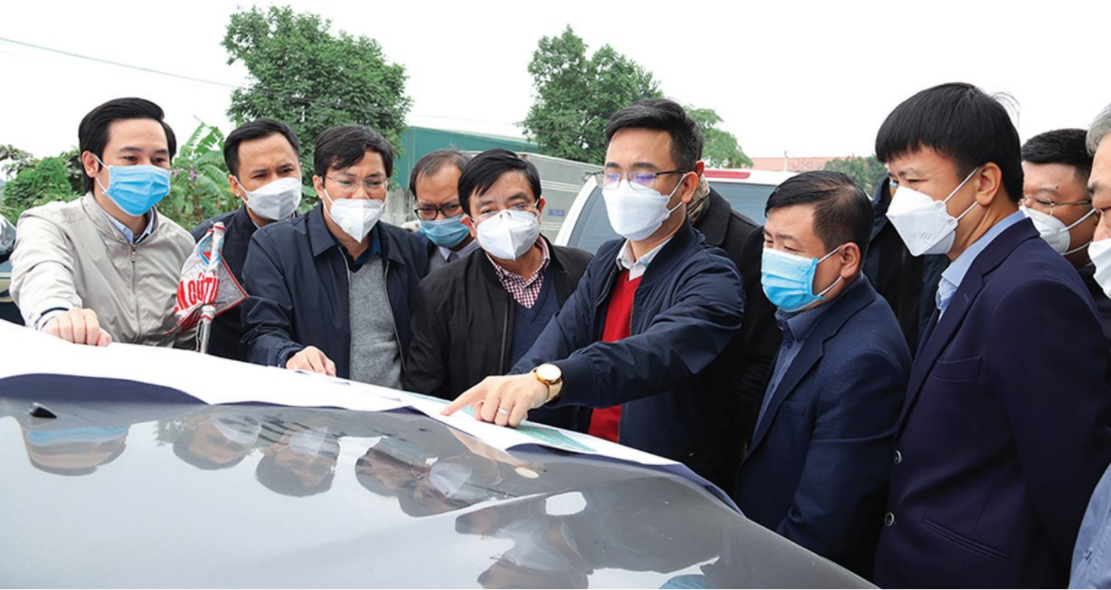
Lãnh đạo Văn phòng Ban chỉ đạo Quốc gia về phát triển điện lực cùng lãnh đạo EVNNPT kiểm tra tiến độ thi công Dự án đường dây 500/220kV Nho Quan - Phủ Lý - Thường Tín, tháng 12/2021
