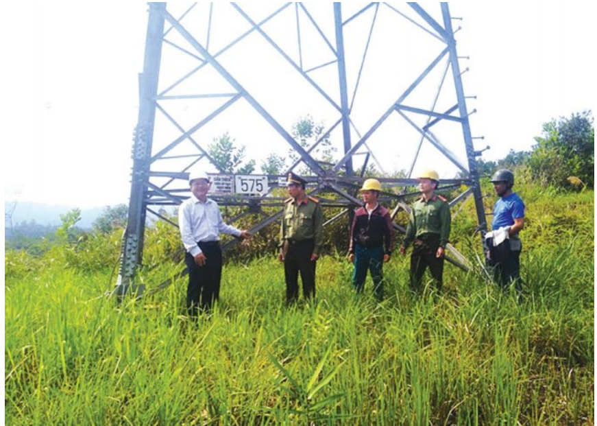
Phối hợp kiểm tra đường dây 500kV Di Linh - Tân Định
