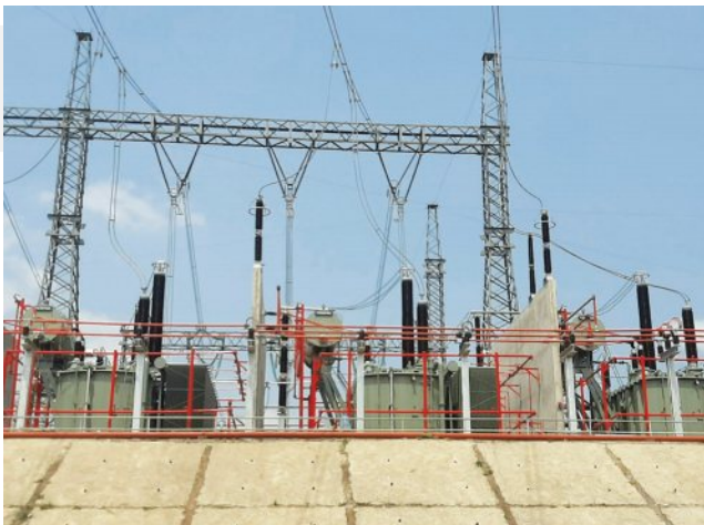
Dự án có quy mô: Thay thế 02 MBA 500/220/35kV - 450MVA
