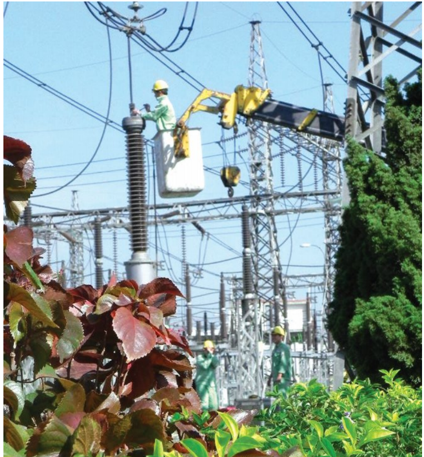
Công tác giám sát siết đầu cos tại trạm năm 2020
