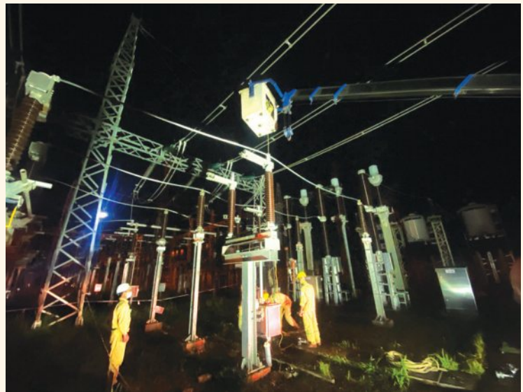
Các đội thi công tranh thủ thời gian cắt điện để thi công không quản ngày đêm
