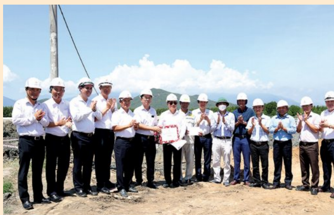
Đoàn công tác EVNNPT do Tổng giám đốc Phạm Lê Phú dẫn đầu tặng quà, động viên lực lượng thi công vị trí 25 thuộc gói thầu số 5, đường dây 500kV Vân Phong - Vĩnh Tân
