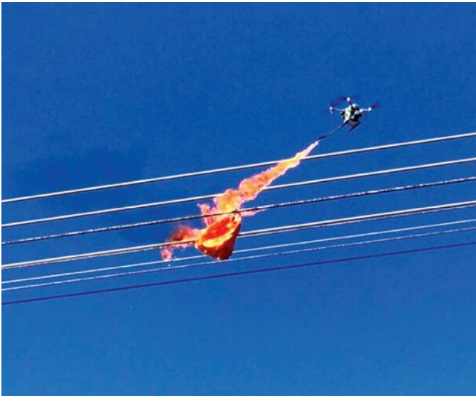
Điều khiển Flycam phun lửa đốt vật bay vướng vào đường dây
