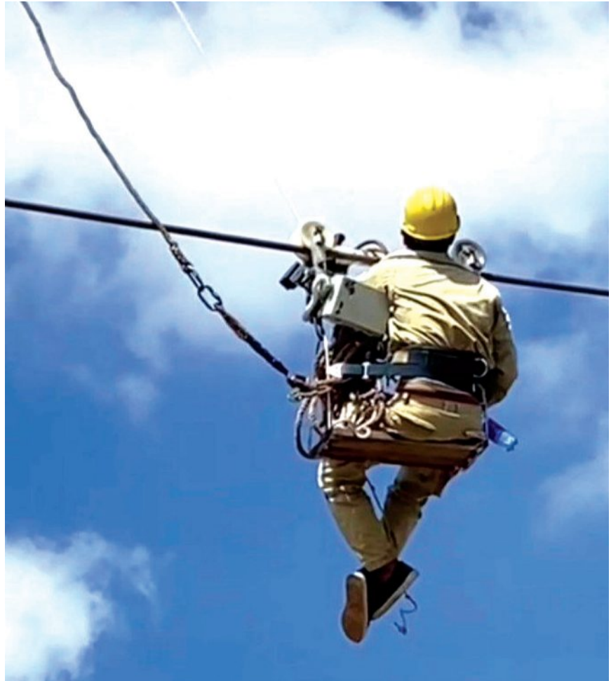
Dùng xe điện ra dây dẫn trên không
