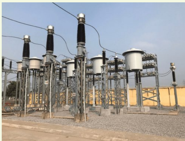
Lắp đặt giàn tụ bù T102 tại TBA 220 kV Vĩnh Yên
