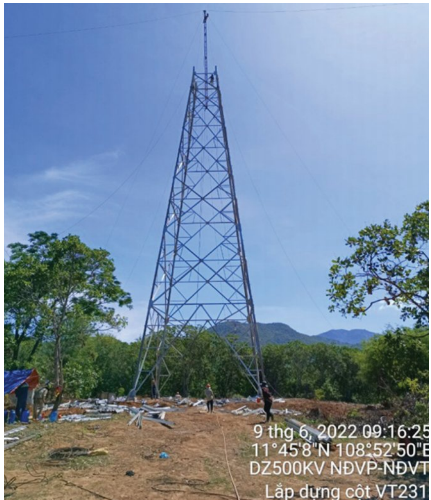
Thi công lắp dựng cột vị trí 231 đường dây Vân Phong - Vĩnh Tân thuộc địa bàn tỉnh Ninh Thuận, ngày 9/6/2022
