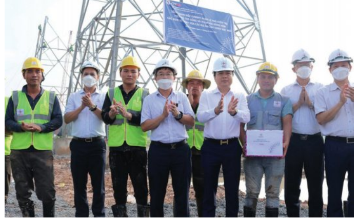
Đ/c Phạm Lê Phú - Tổng Giám đốc EVNNPT tặng quà lực lượng thi công tại vị trí 27 Đẩu nối 500 kV của TBA 500 kV Đức Hoà và đấu nối
