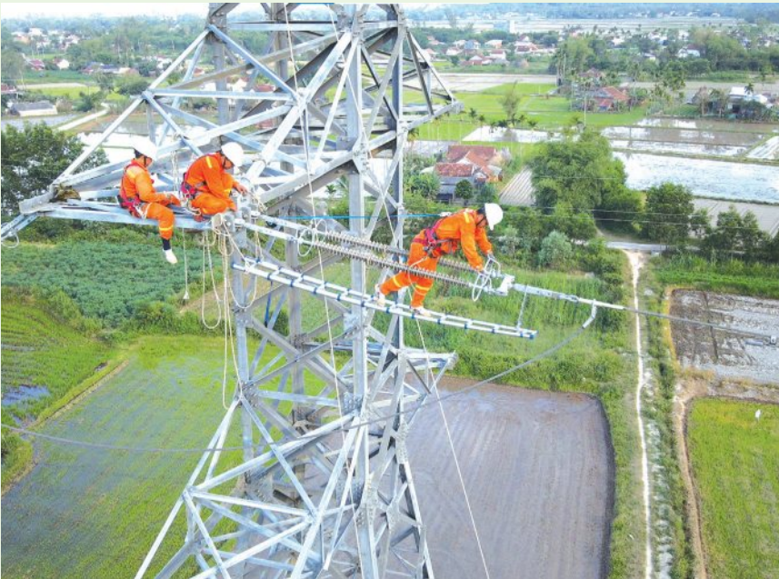
Thay chuỗi cách điện Composite pha B tại vị trí 01 đường dây 220 kV 275/Quảng Ngãi - 273/Phù Mỹ ngày 14/5/2022
