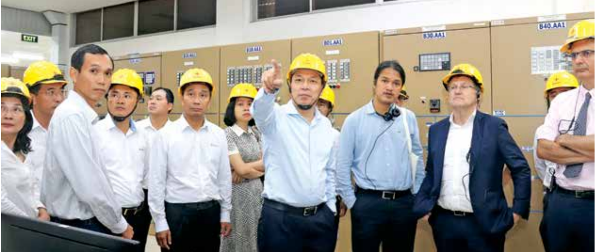
Đoàn công tác của Bộ Công Thương thăm phòng điều khiển tại TBA 500 kV Pleiku
