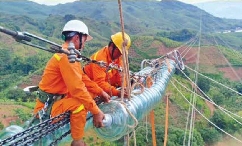
Công trình được thực hiện với độ cao trung bình lớn hơn 50m, các hạng mục thi công chính là thay thế cách điện Composite hiện hữu bằng cách điện thủy tinh, 06 chuỗi đỡ đơn; thay thế sứ phóng; thay thế vòng đẳng, thay thế mắt nối đơn chuỗi đỡ lèo. Trong ảnh: Thi công thay sứ cách điện thủy tinh đường dây 500kV Sơn La - Hòa Bình
