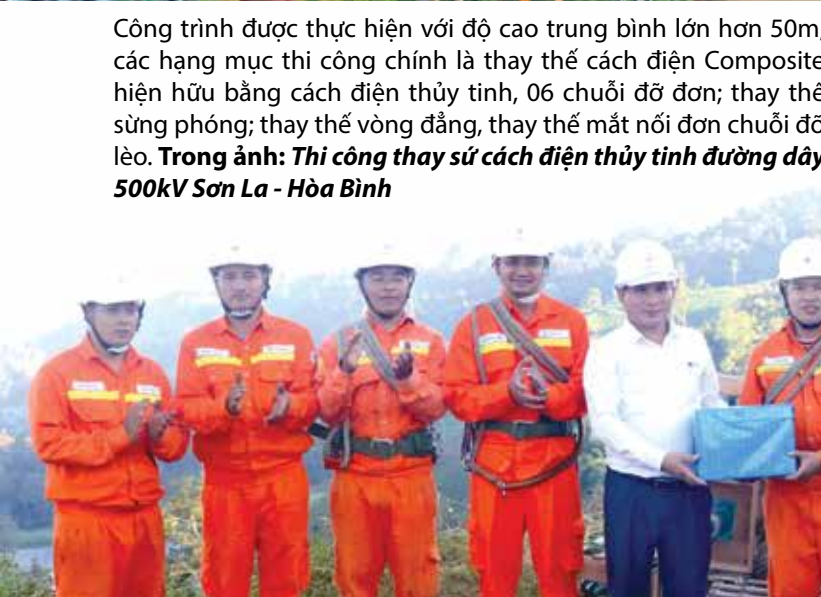
Sau 2 ngày làm việc, công trình sửa chữa lớn đường dây 500kV Sơn La - Hòa Bình đã hoàn thành, trả lưới đúng tiến độ. Trong ảnh: Ông Nguyễn Văn Sơn - Giám đốc TTTĐ Tây Bắc 2 cùng Công đoàn CSTV Tây Bắc 2 thăm và tặng quà anh em đang thi công trên tuyến khu vực đội Mai Sơn quản lý
