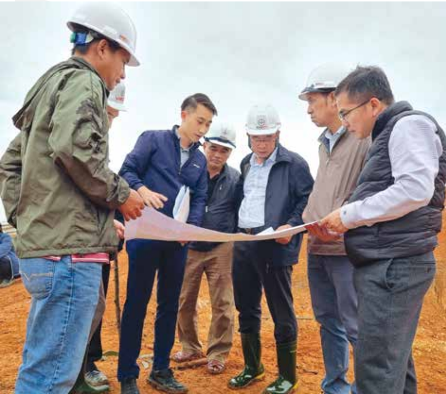
Kiểm tra hiện trạng thi công phần móng đoạn qua Thanh Hóa
