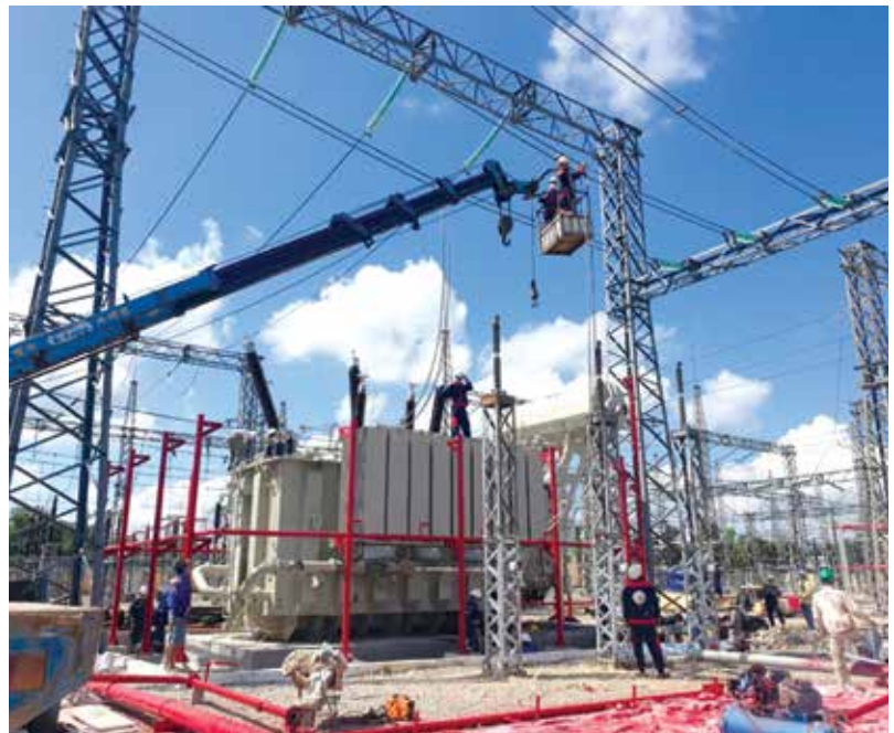
Trong năm 2022, EVNNPT đã thực hiện thủ tục thu xếp vốn vay trong nước cho 72 dự án với tổng giá trị vay là 26.770 tỷ đồng. Ảnh: Thi công dự án nâng công suất trạm biến áp 220kV Huế
