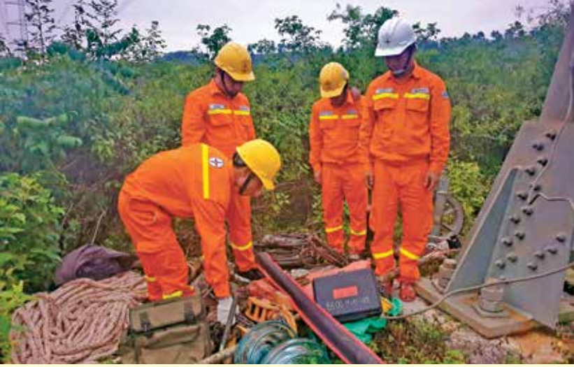
Chỉ tính riêng dụng cụ thi công lên 07 vị trí theo điều kiện địa hình là 2,8 tấn. Đáng kể hơn là 13 tấn vật tư vận chuyển lên từng vị trí thi công đã được chở, gánh trên đôi vai của những người lính truyền tải điện. Trong ảnh: Kiểm tra vật tư, thiết bị, dụng cụ thi công trước khi bắt đầu công việc
