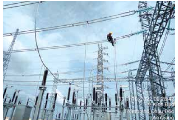
Thi công lắp đặt nhất thứ.
