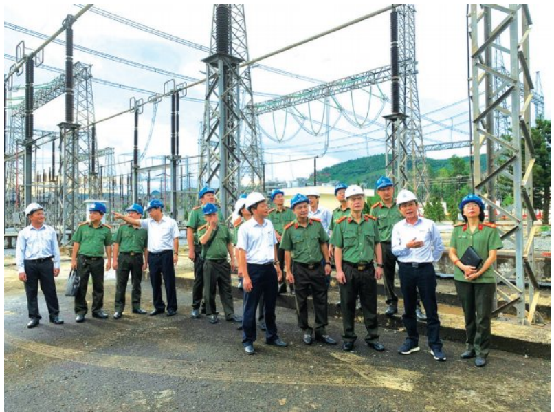
Cục An ninh Kinh tế - Bộ Công An kiểm tra hiện trường tại TBA 500 kV Đà Nẵng
