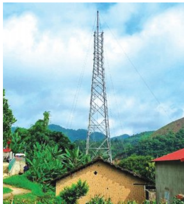
Một vị trí cột đường dây 220 kV Bắc Giang - Lạng Sơn bị vướng mắc về giải phóng mặt bằng
