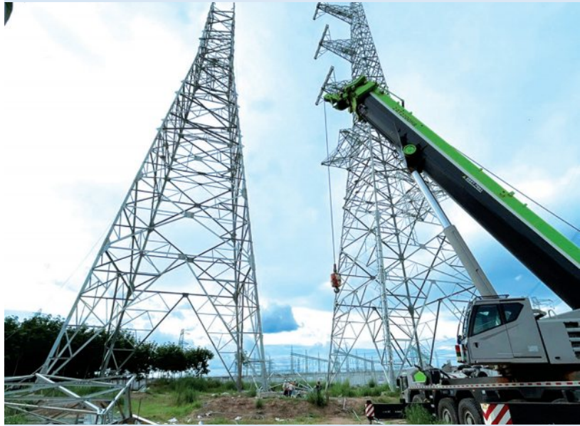
Thi công dựng cột vị trí 253 đường dây 500 kV Đức Hòa - Chơn Thành đoạn qua địa phận tỉnh Bình Dương
