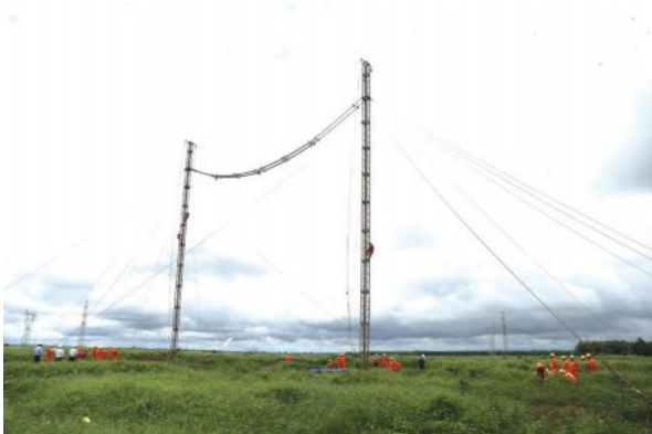
Dựng 1 cột đỡ KEMA chữ H thay thế vị trí 260 đường dây 500 kV EaNam - Di Linh
