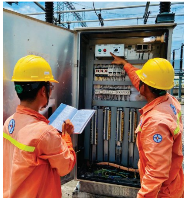
CBCNV Trạm 500 kV Nhà Bè kiểm tra tình trạng vận hành của thiết bị
