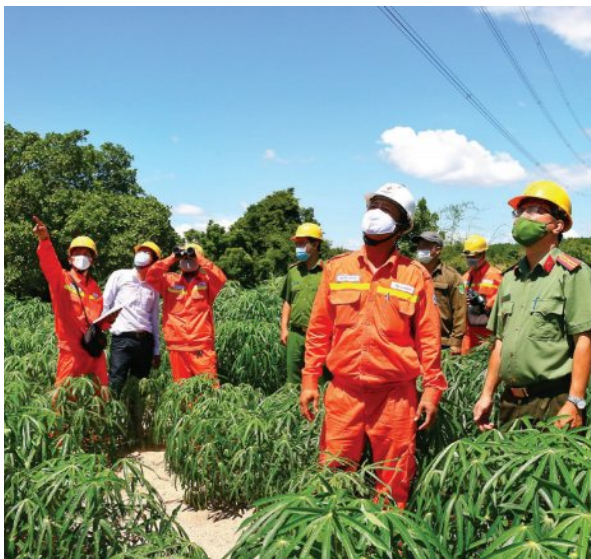
Đoàn công tác kiểm tra các vị trí xung yếu trên đường dây 500 kV Vĩnh Tân - Sông Mây
