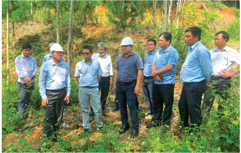
Lãnh đạo CPMB kiểm tra hiện trường thi công đường dây 220 kV Bắc Giang - Lạng Sơn
