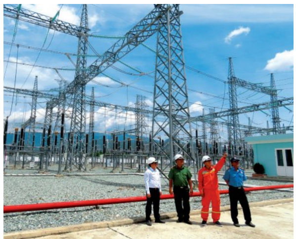
Kiểm tra tại Trạm biến áp 220 kV Tháp Chàm
