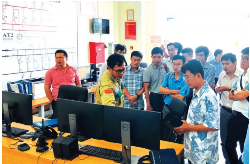
Các học viên được được chia sẻ thông tin tại phòng điều khiển trung tâm TBA số 220 kV Thủy Nguyên
