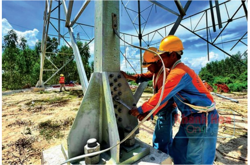
Dựng cột tại xã Ninh Lộc, thị xã Ninh Hòa.
