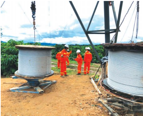
Công nhân PTC2 sửa chữa, bảo dưỡng đường dây 500 kV mạch 1 Đà Nẵng - Thạnh Mỹ - Pleiku
